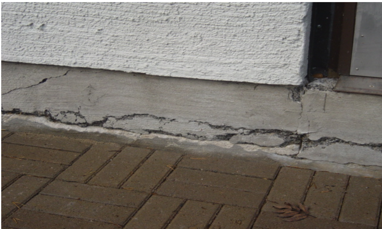
Kuva 1. Sokkelin halkeamia.
