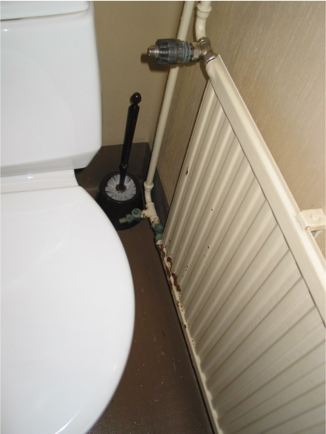
Kuva 4. Ruostunut lämpöpatteri.
