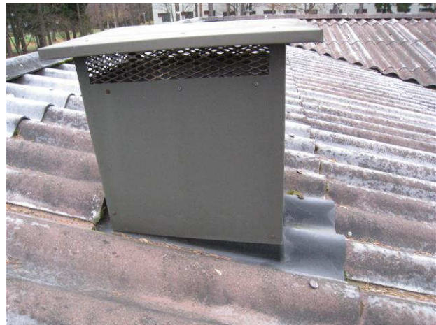
Kuva 20 Ullakon (oletettu) tuuletuspiippu.
