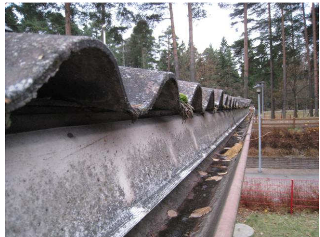
Kuva 16 Räystäällä on vedenohjauspellit ränneihin, vesikatteen alla on aluskate.
