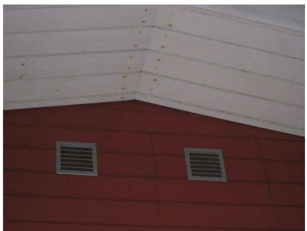
Kuva 24 Itäisivun harjapäädyssä oleva välttävä kulkureitti ullakolle.
