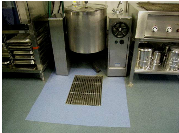
Kuva 38 Keittiön padan lattiakaivon ympäriltä on uusittu lattiamattoja.
