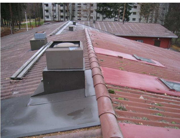
Kuva 17 Yleiskuva pohjoiseen monitoimihallin 40 kohdalta, jonka kate on uusittu.
