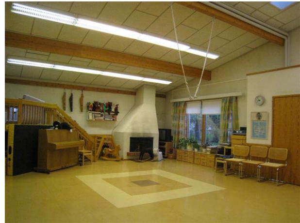
Kuva 44 Yleiskuva monitoimihalliin 40. Rungon liimapuupalkit ovat esillä, lämpöputkien runkolinjoja on katossa.
