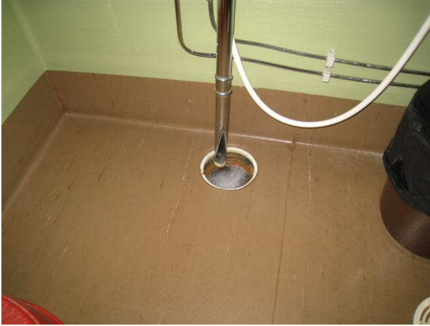
Kuva 31 Wc-tilassa on alkuperäinen muovimatto ja seinätapetti. Käyttövesiputket ovat esillä.
