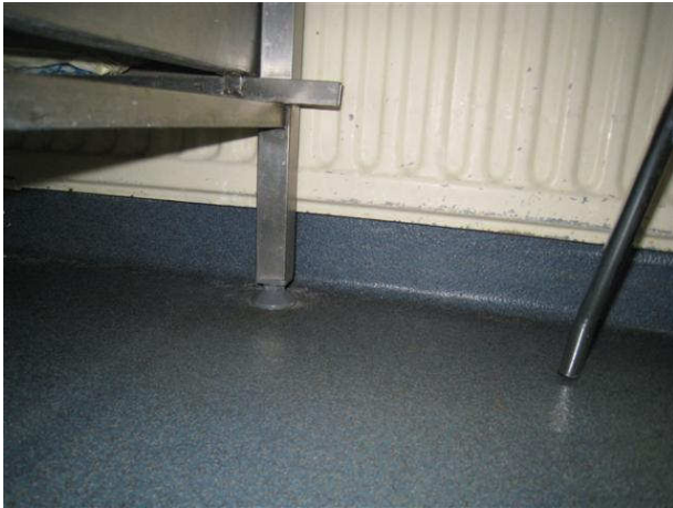
Kuva 37 Keittiön lattiamaton juurinosto.
