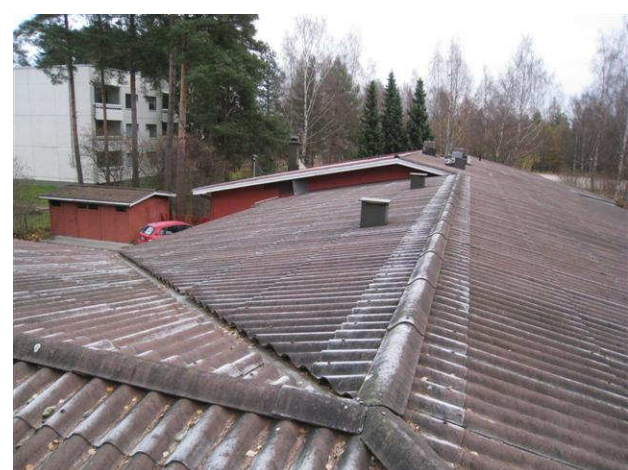
Kuva 18 Yleiskuva pohjoisosan jiiren risteämsästä eteläosan suuntaan.
