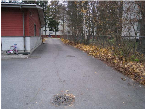
Kuva 1 Huoltopihan asfalttien pintakallistukset ovat riittävät. Sadevedet on ohjattu kallistuksin sadevesikaivoihin.
