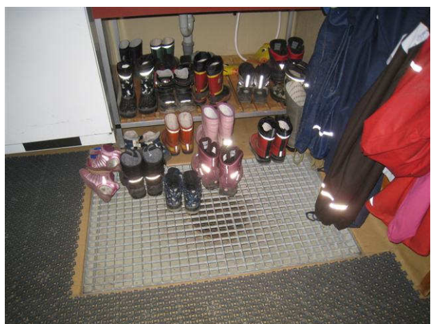
Kuva 36 Tk-märkäeteisen lattiakaivo ja ritilä.
