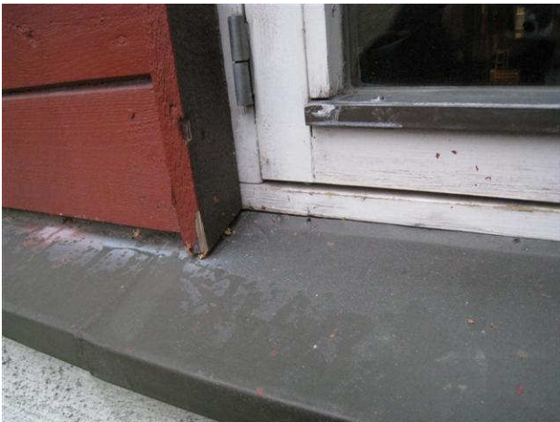
Kuva 9 Ikkunanpielilauta vasten vesipeltiä.
