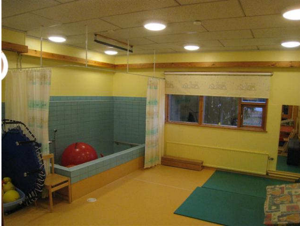
Kuva 43 Yleiskuva terapiahuoneeseen 44, jonka altaan taustaseinä on korjattu.
