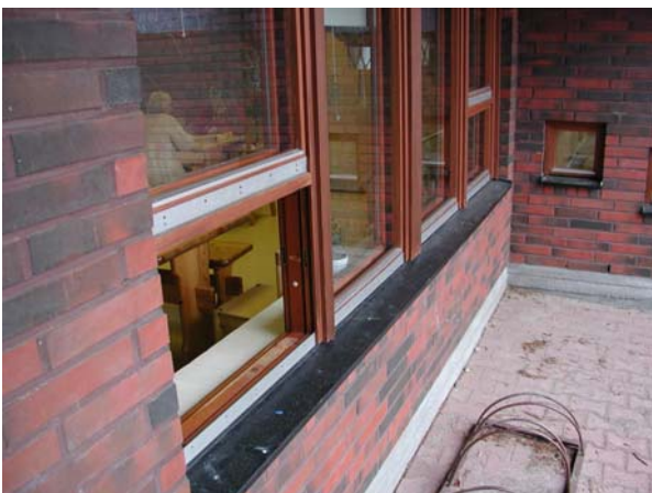
Kuva 3. Ikkunat ja pellitykset ovat hyväkuntoiset.
