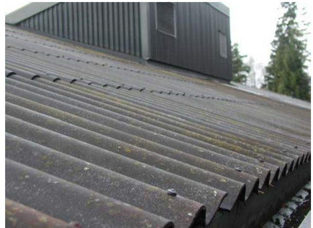
Kuva 5. Vesikaton kunto on silmämääräisesti tyydyttävä.
