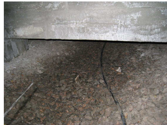
Kuva 10 B-osan palkkialituksen kohdalla on va- paata vettä.
