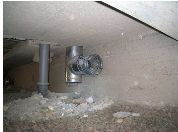
Kuva 8 Poistoilman pääte-elin.
