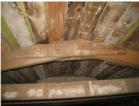
Kuva 27 Peltikatteen alla on harvalaudoitus
