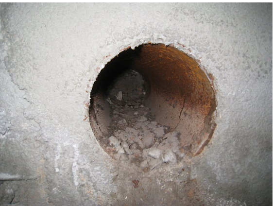
Kuva 9 Alustatilan tuuletusputki. Sisällä sepe- liä ja hienoainesta.
