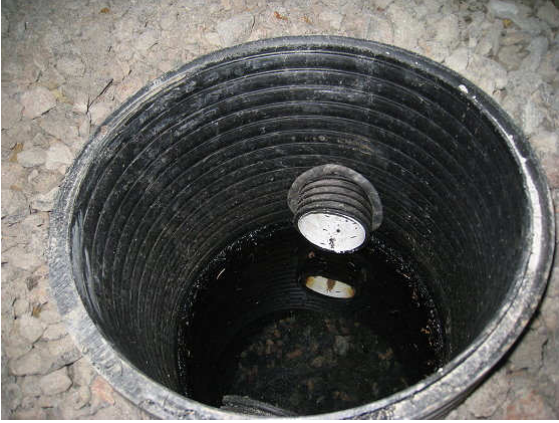
Kuva 23 B-osalla oleva salaojan tarkastuskaivo.
