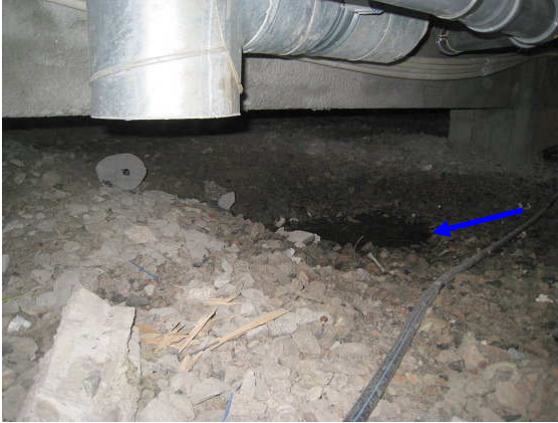
Kuva 11 Vapaata vettä D-osalla. Sepelitäytön pinnalla puun säleitä.
