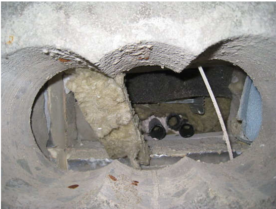
Kuva 19 D-osalla timanttiporausreikiä, joita ei ole suljettu.
