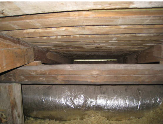
Kuva 33 Yläpohjien tuulettuminen vaikutti riittävältä.
