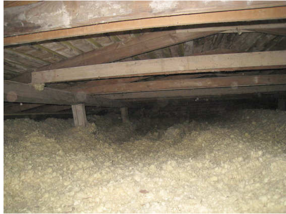
Kuva 26 Lämmöneristeenä puhallusvillaa.
