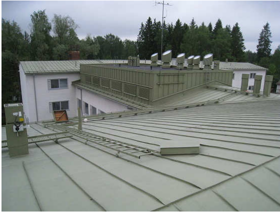
Kuva 25 Rakennuksessa on peltikate IV-konehuoneen bitumihuopakatetta lukuun ottamatta.
