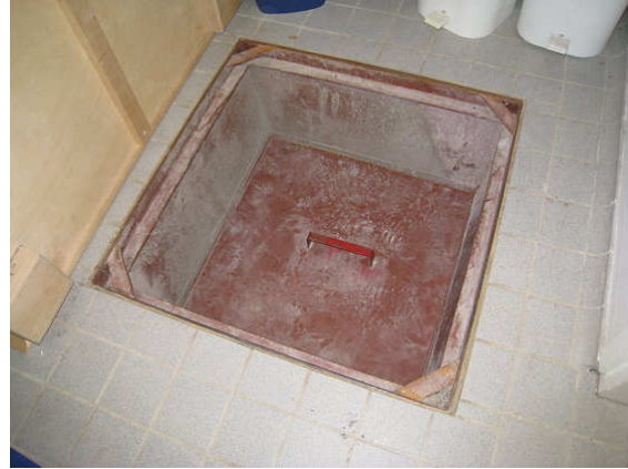
Kuva 6 Lattialuukku E-osan alustatilaan.
