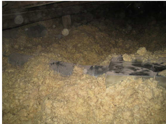
Kuva 32 Eristämätöntä IV-kanavaa.
