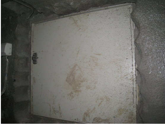
Kuva 5 Peltiluukku A- ja B -osien alustatiloihin.
