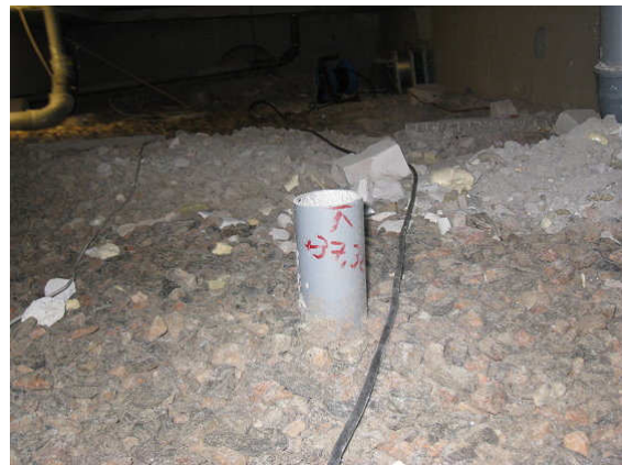
Kuva 22 Pohjaveden mittauspiste B-osalla. Se-peli kostea.
