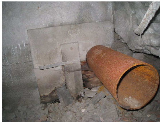
Kuva 15 Kosteus- ja mikrobivaurioitunutta vaneria D-osalla.
