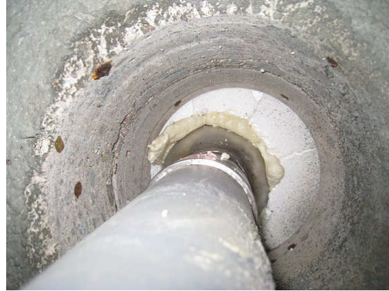
Kuva 18 Tyypillinen viemäriäpivienti.
