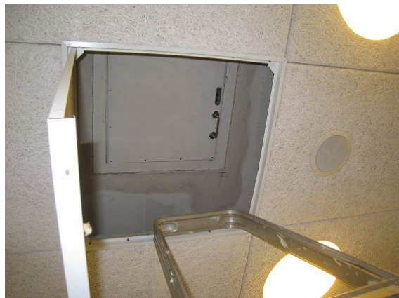
Kuva 28 Porrashuoneen 303 sisäänkäynti yläpohjaan.
