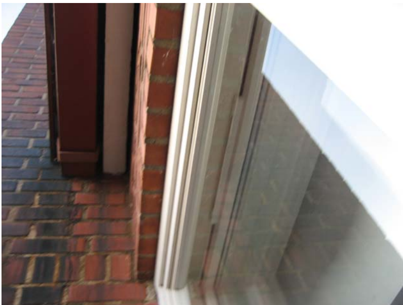
Kuva 5. Huoneiston yläpuoliselle vesikatolle ei ole pääsymahdollisuutta (ei kattoluukkuja) ja esimerkiksi räystäskourun pään toimivuutta (vuotamattomuutta) ei voitu tarkastaa kourun yläpuolelta (sitä, ettei kourun päästä ole tapahtunut vuotoja piippupinnalle).
