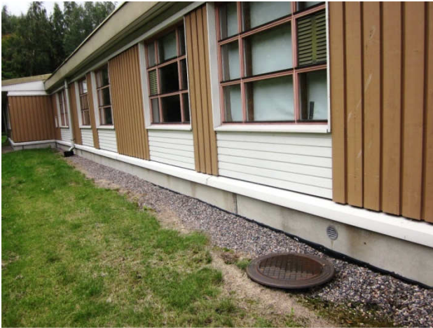
Kuva 9 Kaivon kansiosa maanpinnan yläpuolella.
