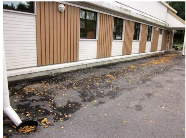
Kuva 4 Alustatilan tuuletusventtiilit ovat lähellä asfaltin pintaa.
