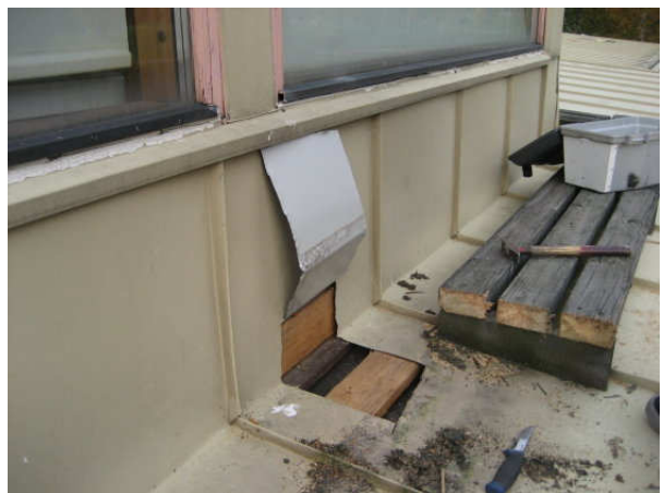
Kuva 46 Avauskohta 3 tehtiin IV-konehuoneen edessä olevan parven ikkunan eteen.
