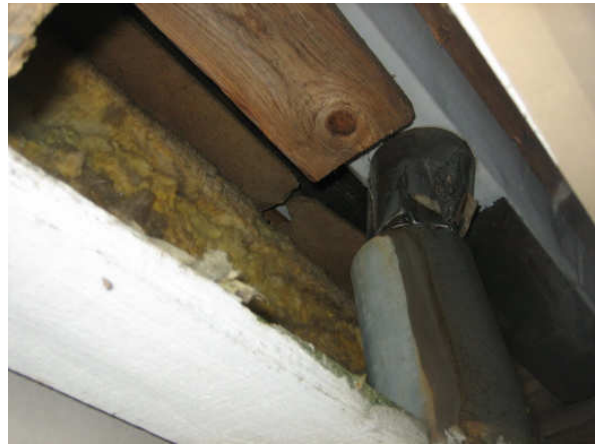
Kuva 20 Syöksytorvi oli lähes irti 59 kulmalla.
