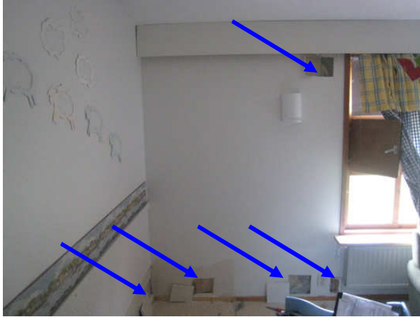
Kuva 5 Yleiskuva huoneesta 59, johon tehtiin useita 2.8.07 tutkimusaukkoja seiniin ja yksi kattoon.
