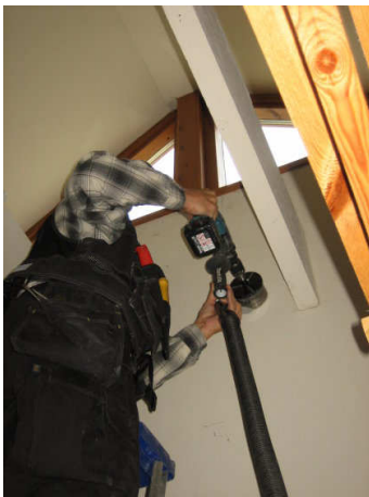
Kuva 25 Kattolyhdyn pystyseinään tehtiin tutkimusta varten reikiä eteistilassa 57.
