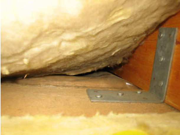
Kuva 23 Yläpohjan palkkien liitos ulkoseinään, villan alla on höyrynsulkumuovi.
