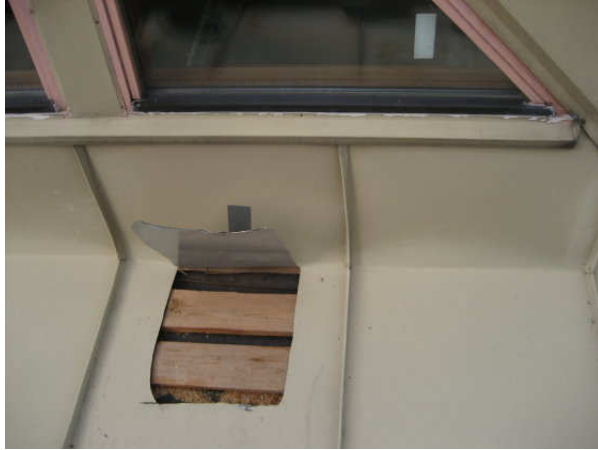
Kuva 53 Avauskohta 8, joka tehtiin tilan 12 kohdalle.
