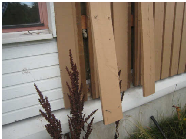
Kuva 10 Huoneen 59 ikkunan pielen lautoja irrutettiin taustan tutkimiseksi.
