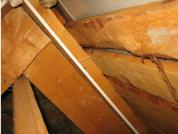
Kuva 35 Kattolyhdyn umpipäädyn ja yläpohjan liitos, jossa kipsilevy on tuulisuoja. Rakenteet ovat kuivia.
