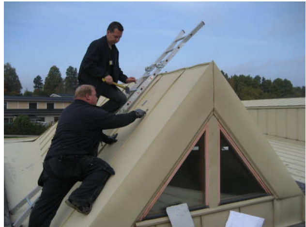
Kuva 38 Kattolyhdyn yläpohjaan avattiin tutki- musaukko, Avauskohta, 6 tilan 23 koh- dalla 26.9.2007.
