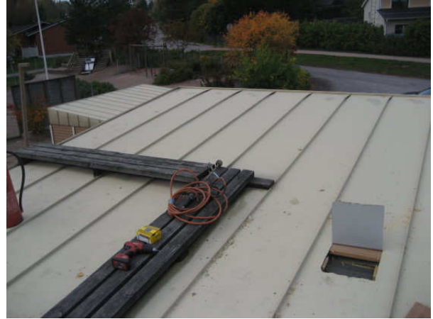
Kuva 48 Avauskohta 4, joka tehtiin keittiötilan 33 yläpuolelle.
