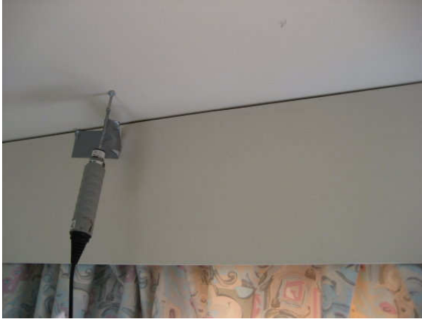
Kuva 11 Viiston yläpohjan eristestilan porareikäkosteusmittauspaikka PR1 10.9.2007 huoneessa 46.
