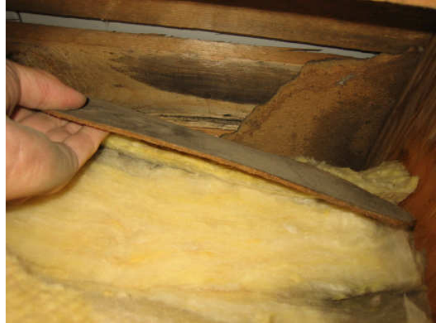
Kuva 24 Räystäällä on yläpohjan ruoteissa ja kovalevyssä vesijalkia ja mikrobeja. Villoissa on tummumia.
