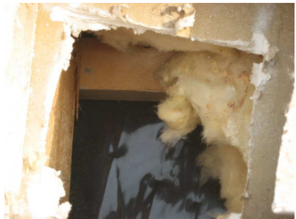
Kuva 40 Avauskohta 6 yläpohjan villa on terveen värinen ja sen alla on höyrynsulku.
