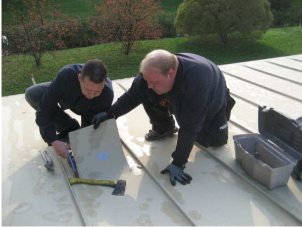
Kuva 41 Avauskohta 1 kattolappeella tilan 59 yläpuolella.
