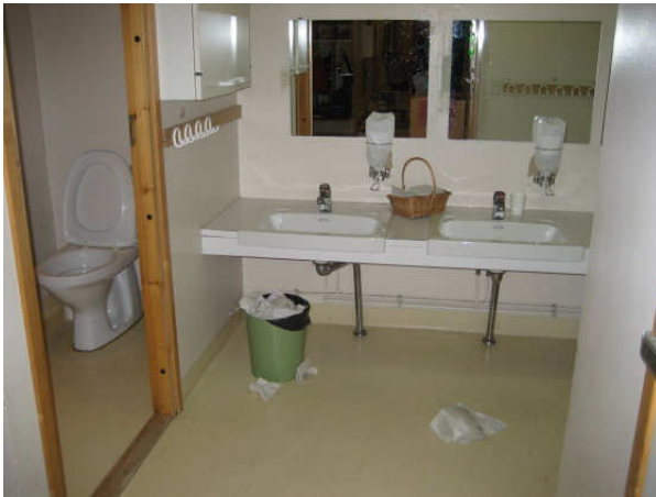
Kuva 13 Yleiskuva eteistilan altaista eteistilassa 07, vasemmalla vieressä on wc-tila 08. Pinnat ovat hyvässä kunnossa.
