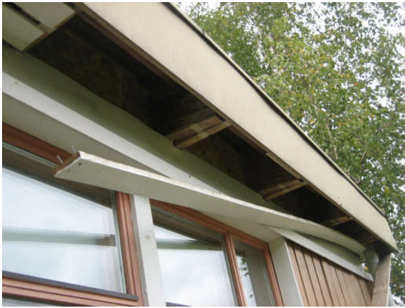
Kuva 19 Räystään avauskohta 59 kohdalla.
