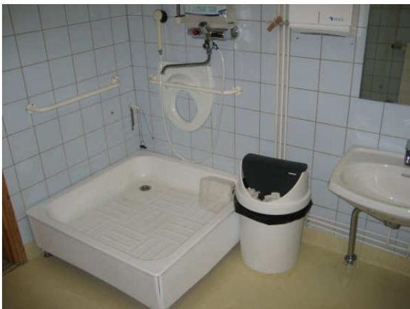
Kuva 15 Pesuhuone 13 suihkunurkka vaikutti hyväkuntoiselta.
