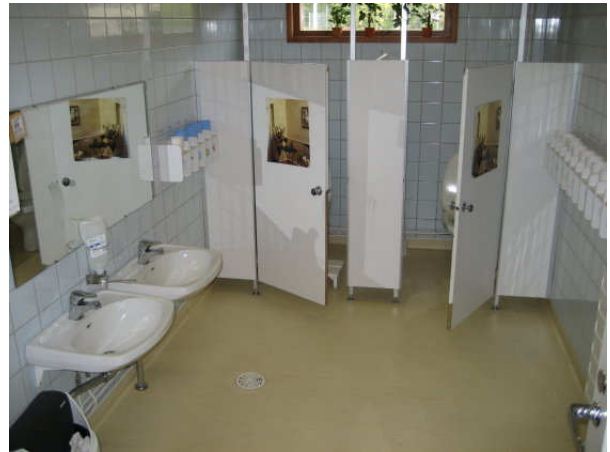
Kuva 14 Pesuhuone 13, jonka pinnat ovat hyvässä kunnossa.
