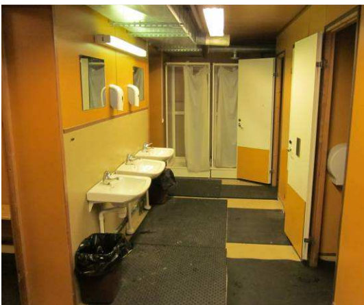
Yleiskuvaa Wc- ja suihkutilasta
