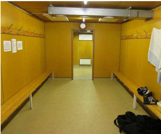
Yleiskuvaa pukuhuonetilasta, yleisilme siisti
