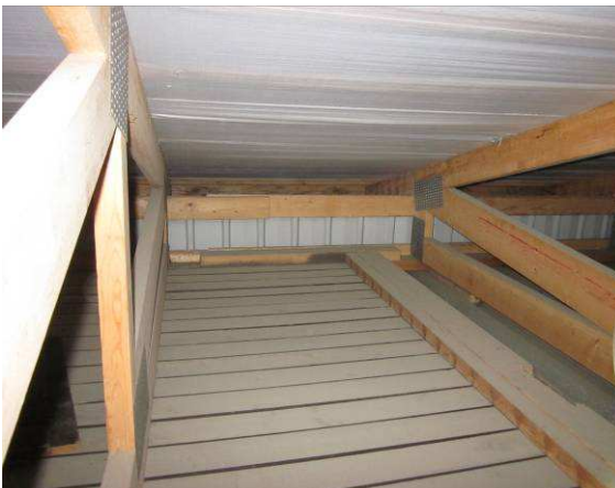
Yläpohjatilassa ei havaittu vuotojälkiä
