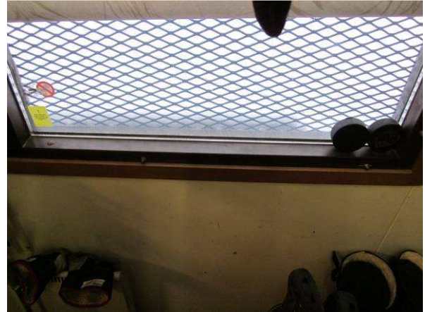
Kuvaa ikkunasta sisäpuolelta
