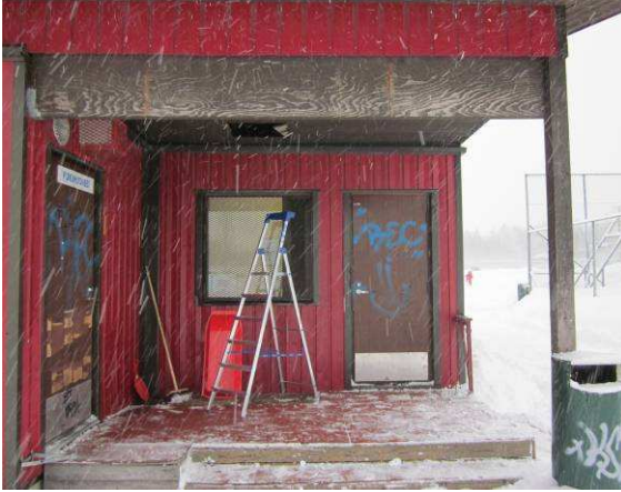
Puuverhoilujen ja osien huoltomaalaus ajankoh- Julkisivupinnoilla on graffiteja taista
