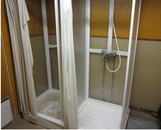
Kuvaa suihkukaapeista, suositellaan uusimista/suihkukaappien poistamista
