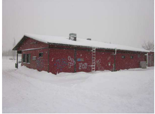
Puuverhoilujen ja osien huoltomaalaus ajankoh- Julkisivupinnoilla on graffiteja taista
