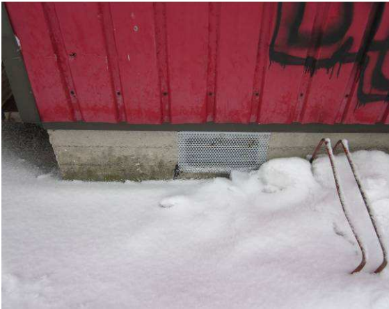
Kohteessa on tuulettuva alapohjarakenne
