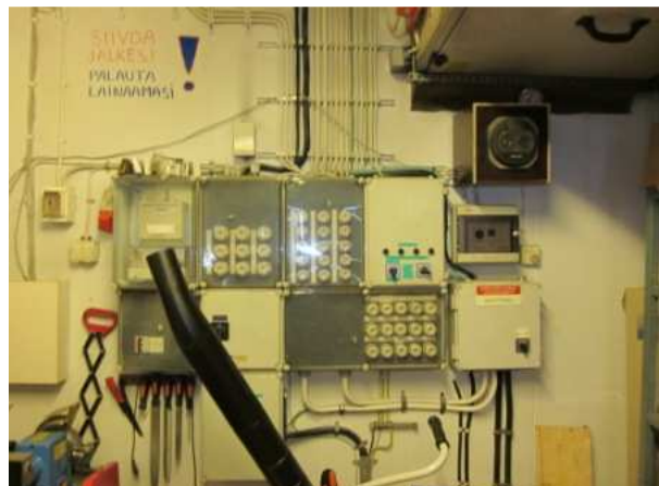
Rakennuksen sähköpääkeskus.
