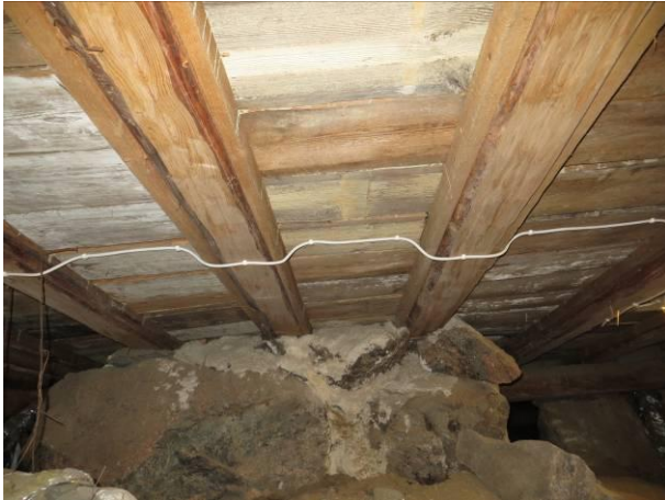
Kuva 9 Tulisijan tai piipun alla oleva kivilatomus keskialueella.
