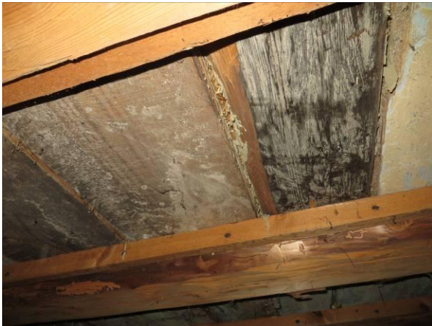
Kuva 23 Olkieriste pilkottaa laudaraosta.
