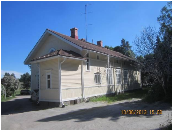
Kuva 1 Pohjoispääty ja itäisivu, jossa maasto viettää kohti rakennusta, mutta on tehty loiva vastakallistus ja ojanne.
