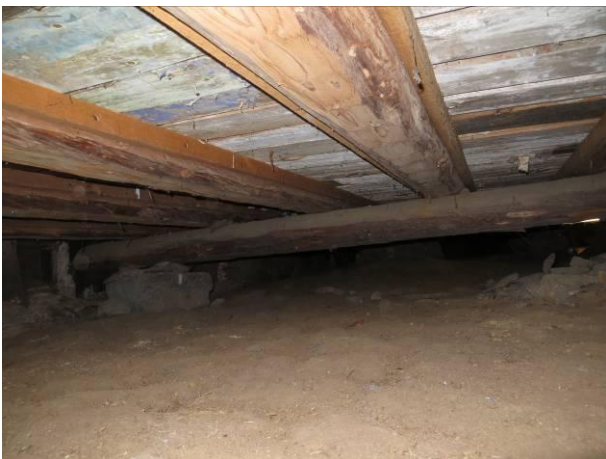
Kuva 21 Keski-alue eteläpäädyssä, kierrätyslautaa, jonka pinnassa on vanha tapetti tasoitteita tv.
