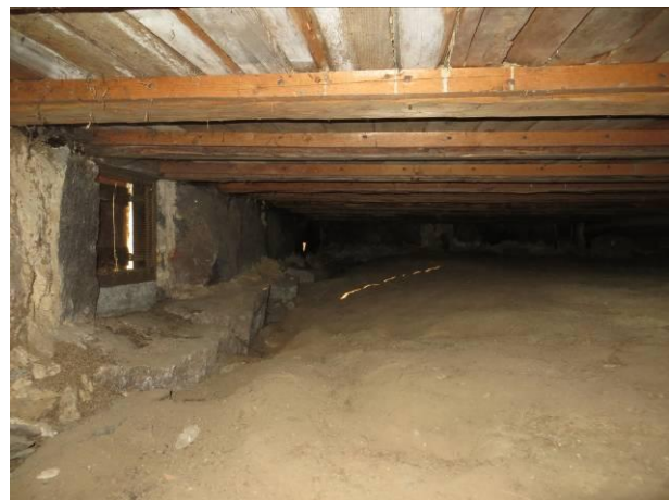
Kuva 20 Eteläpäädyn viereltä, kulkuluukku
