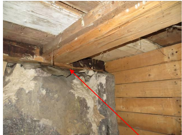
Kuva 24 Kivien ja parrun välissä on kermi.
