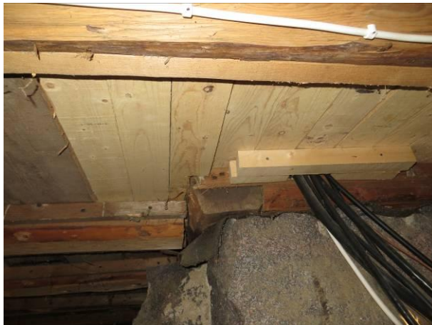
Kuva 25 Uusittuja lautoja.
