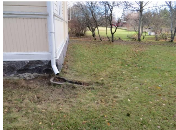
Kuva 2 Eteläpääty, jossa itäisivun ojanne kääntyy eteläpäädyn ohi. Lyhyehkö loiskekouru.
