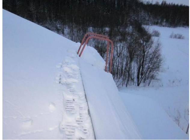
Kuva 6 Talotikkaita ei ole tuettu yläosasta.
