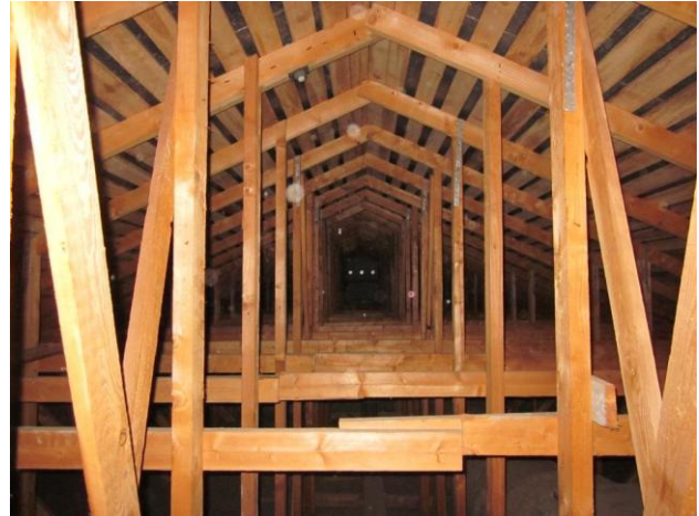
Kuva 2 Raketeissa ei havaittu kosteusjälkiä tai vaurioita.
