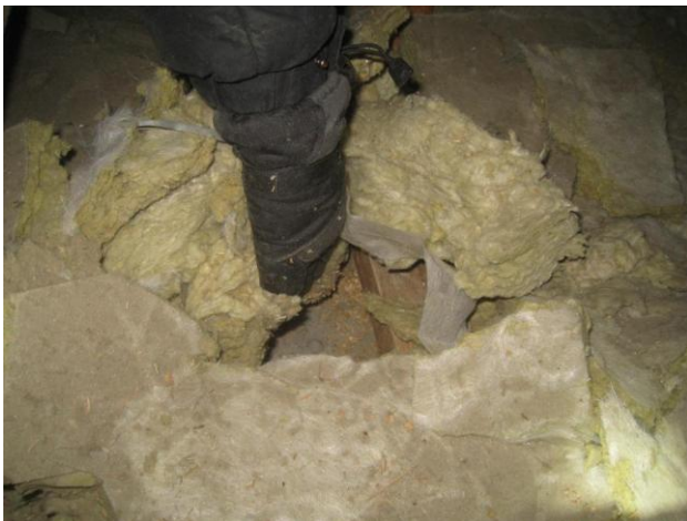
Kuva 3 Yläpohjassa on noin 300 mm mineraalivillaeristys.
