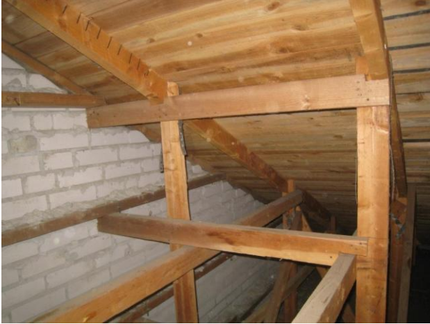
Kuva 5 Tiiliseinän tuenta koulun puoleisessa päädyssä. Kosteusvaurioita ei havaittu.
