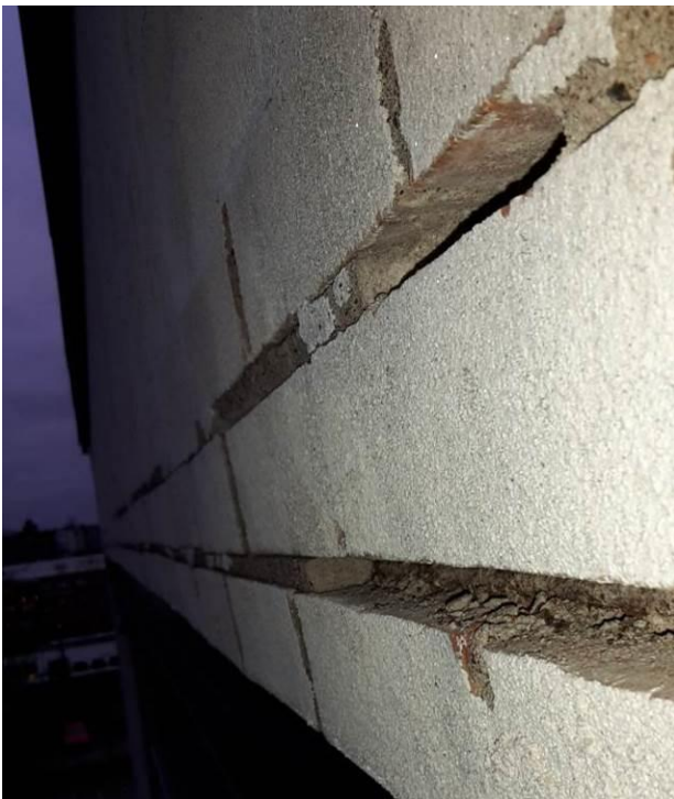
Kuva 2. Julkisivun B yläosa, etelälounaan suuntaan. Alimman vaakasauman harjateräs on ruostunut ja muurauslaasti raudoitteen ulkopuolelta on irronnut tai irtoaa paloina. Betonipeite on noin 35 mm.
