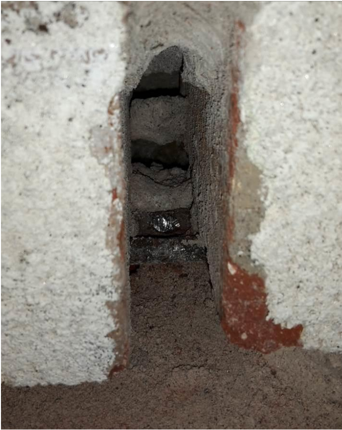
Kuva 3. Julkisivun B yläosa, etelälounaan suuntaan. Raudoitteet piikattiin esiin toisiksi alimmasta vaakasaumasta. Raudoitteet ovat syvällä saumassa (betonipeite n. 65 mm), eikä ruostumista ole havaittavissa. Muurauslaasti murenee raudoitteiden ulkopuolelta helposti piikattaessa.
