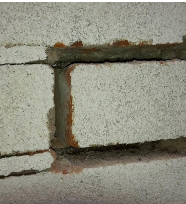
Kuva 8. Julkisivun G yläosa, etelälounaan suuntaan. Tiilisaumaa piikattiin auki kenttäkierroksella. Alimman sauman raudoite on noin 45 mm syvyydessä ja ylemmän sauman noin 60 mm. Raudoitteiden ruostumista ei havaittu. Piikkauskohdassa raudoitteita havaittiin saumoissa vain yhdet.
