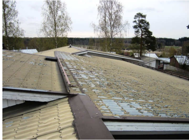
Kuva 22 Pinnoite kuorittunut pellin pinnasta.
