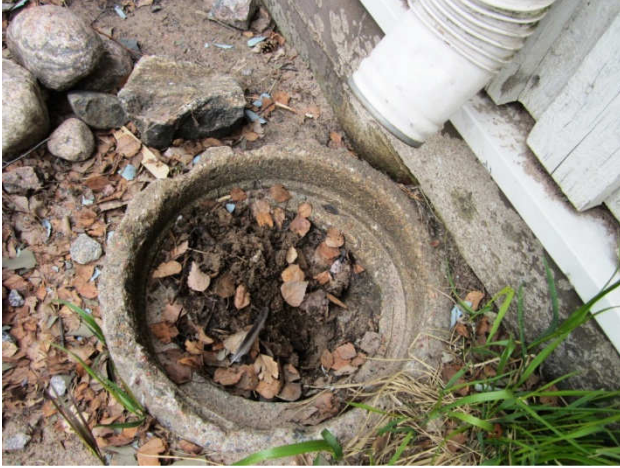
Kuva 3 Kattovesikaivo tai kivipesä.
