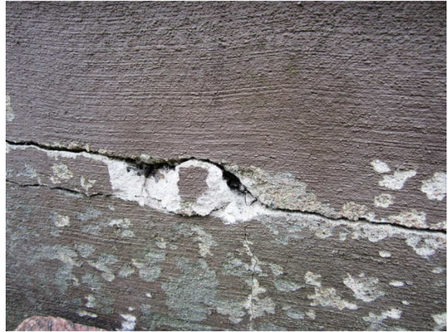
Kuva 6 Sokkelissa halkeamia kevytsoraharkon laastisaumojen kohdilla.
