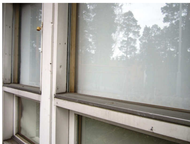
Kuva 16 Yläikkunan karmi suojattu pellillä.
