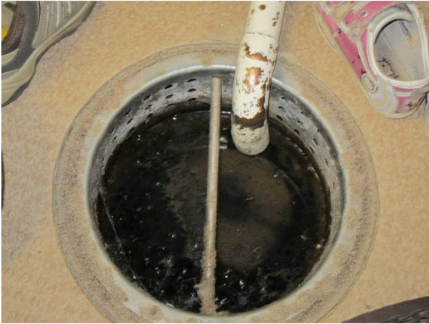
Kuva 25 Märkäeteisen lattiakaivo hiekkapesälä.
