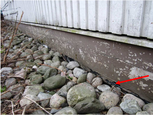
Kuva 5 Perusmuurin ulkopinnassa mustaa muovia.
