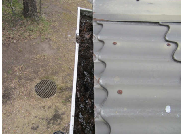
Kuva 4 Syöksytorvi tukkeutunut.
