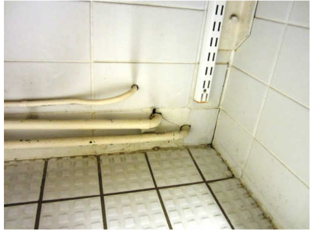
Kuva 26 Tiivistämättömiä läpivientejä.
