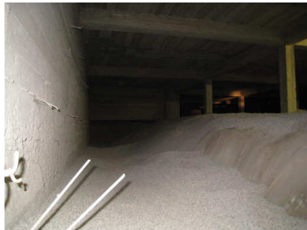
Kuva 6 Näyttämön alla olevaa alustaa.
