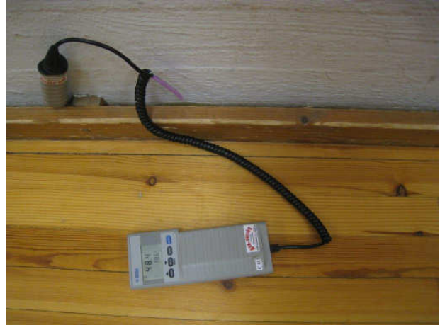
Kuva 20 Kosteusmittaus VTV3 49 %RH.
