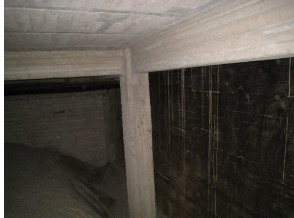
Kuva 14 Aulan alla olevaa alustatilaa.
