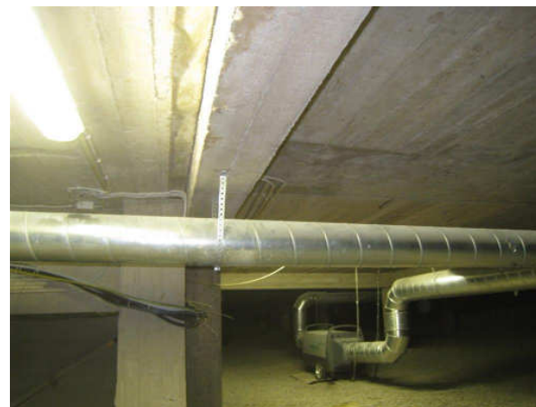
Kuva 11 Salin ja välinevaraston rajalla oleva liikuntasäuma.
