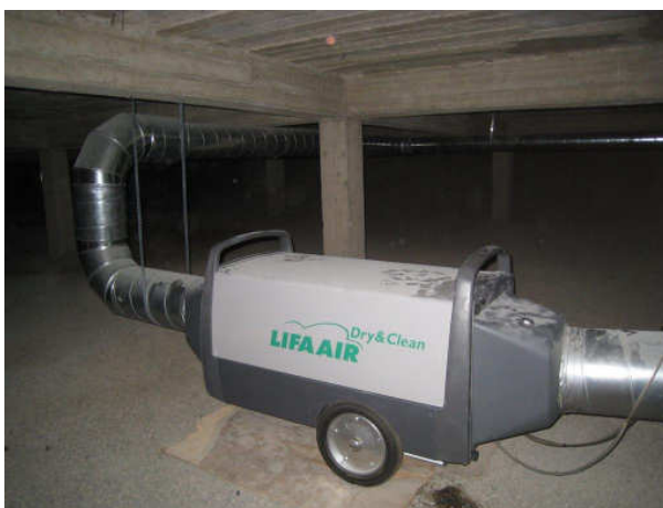
Kuva 5 Alustatilan ilma kiertää tämän läpi.
