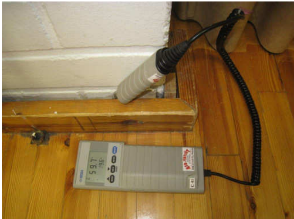
Kuva 18 Kosteusmittaus VTV2 60 %RH.
