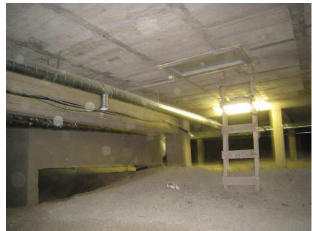
Kuva 10 Välinevaraston kohdalta on luukku alus- tataan.
