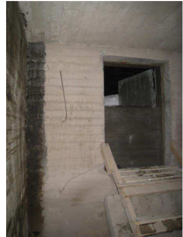
Kuva 2 Kulkuluukku on ollut joskus korkeampi.
