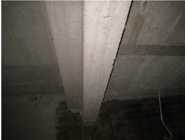
Kuva 13 Liikuntasaumaa kohti aulaa 357.
