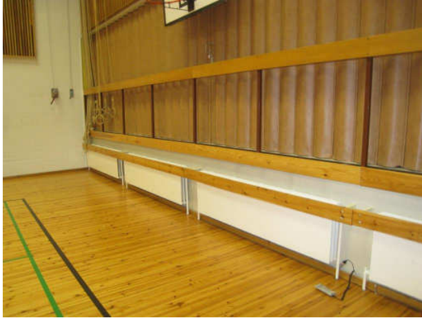
Kuva 25 Kosteusmittaus VTV6 56 %RH.
