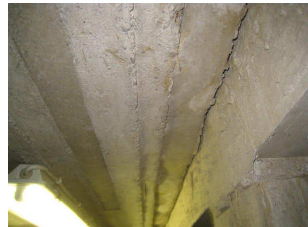
Kuva 12 Liikuntasäuman rako on 5–10 mm, tästä pääsee kostea ilmaa ja mikrobeja.
