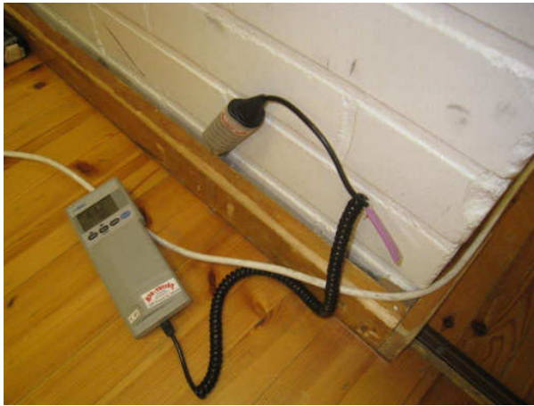
Kuva 27 Kosteusmittaus VTV8 63 %RH. Salin ja varasto 348 rajalla.
