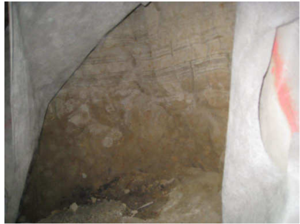
Kuva 8 Jyrkkä pengeri, jossa on kostea savi- maata vain suodatinkankaan takana.
