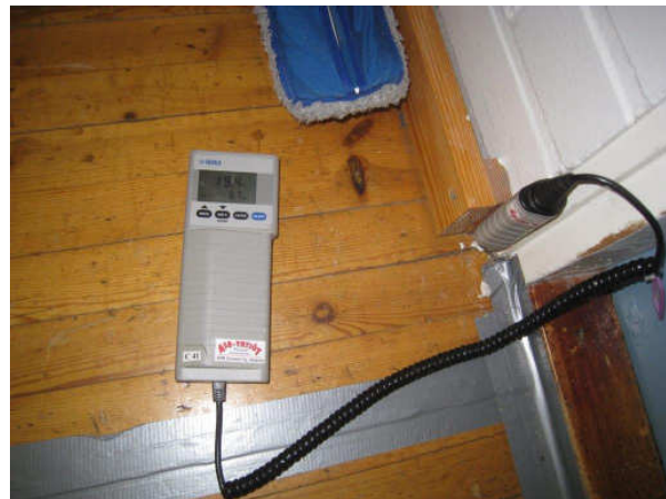
Kuva 16 Kosteusmittaus VTV1 välinevaraston lattialuukun vierestä 40 %RH.
