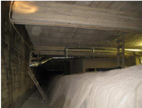
Kuva 9 Välinevaraston 343 alla oleva alue, jossa on jyrkkä pengeri.
