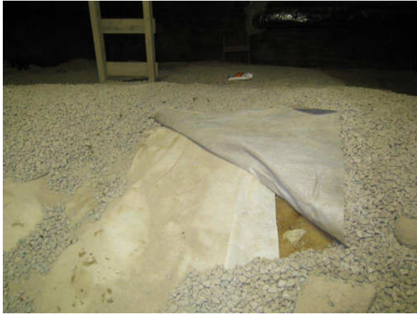
Kuva 7 Salin alla sepeliä, suodatinkangas ja kostea hiekkaa.
