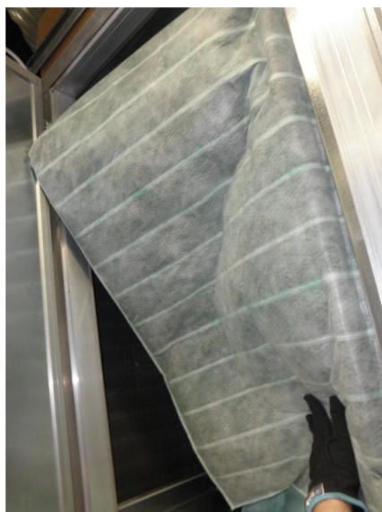
Kuva 8. PK07 poistoilmasuodatin.
