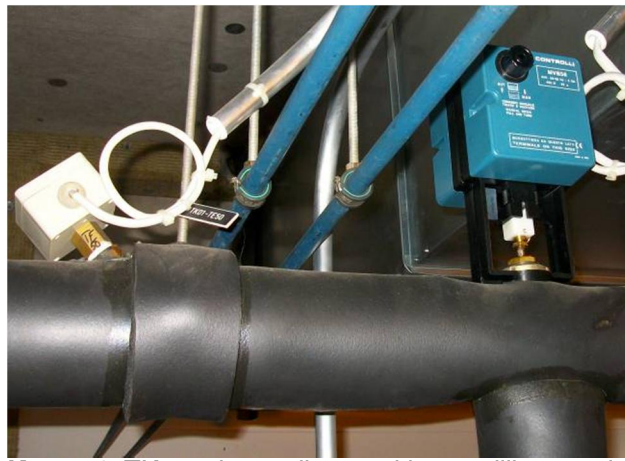
Kuva 51. TK01:n lämpötila-anturi ja venttiilimoottori
