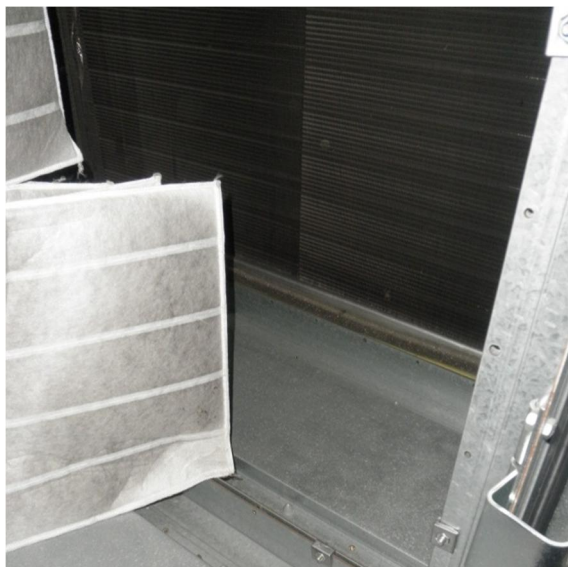
Kuva 17. TK01PF01 suodatinkammio ja LTO-patternin etupinta ovat puhtaat.
