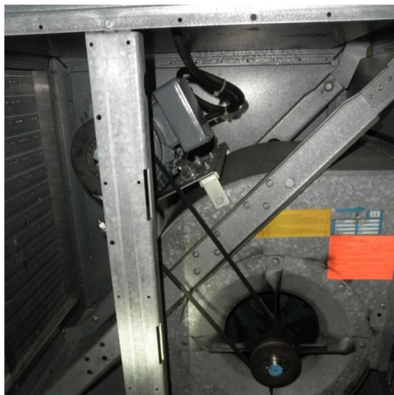
Kuva 18. PF01 poistoilmapuhallin.
