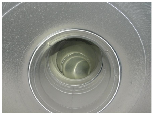
Kuva 24. Pölykertymää poistoilmakanavassa.
