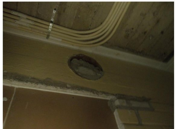
Kuva 30. Käytöstä poistettu kanava alakaton yläpuolella.
