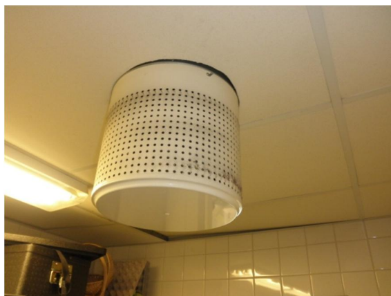
Kuva 37. Keittiössä ja pienemmässä ruokasalissa käytetään myös RAL-tuloilmahajottajia.
