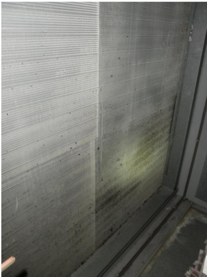
Kuva 11. Myös TK01 LTO-patterin etupinta on lievästi likaantunut.
