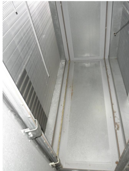
Kuva 12. LTO- ja lämmityspatterien välinen kammio oli puhdas.
