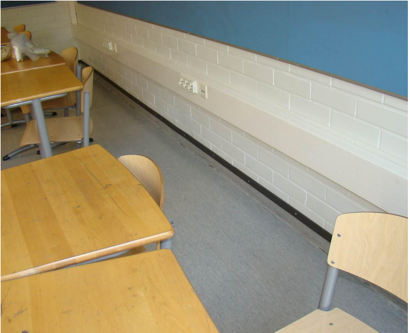
Kuvat 6, 7. Luokkahuoneen 218 ja käytävän väliseinä- ja lattialiittymä. Käytävän ja luokan välinen tiiliseinä menee ylemmän betonilaatan läpi.
