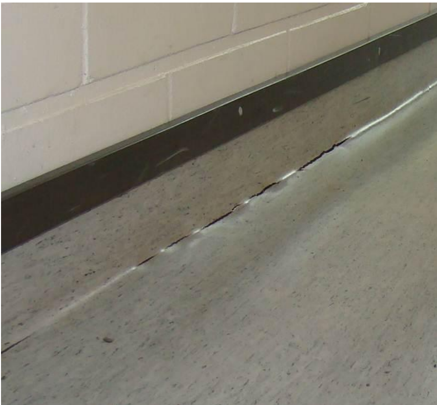
Kuvat 6, 7. Luokkahuoneen 218 ja käytävän väliseinä- ja lattialiittymä. Käytävän ja luokan välinen tiiliseinä menee ylemmän betonilaatan läpi.
