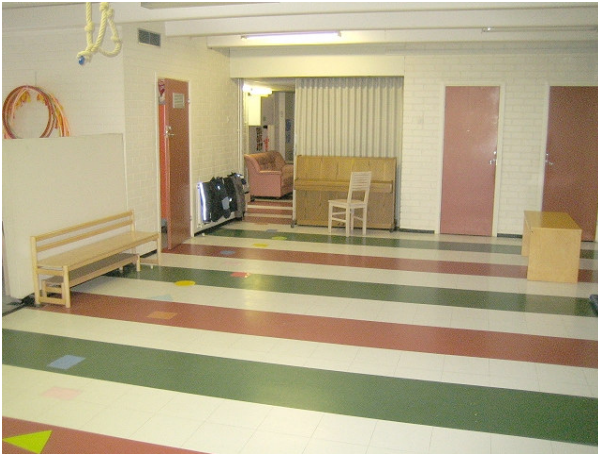
Kuva 1 Tilat olivat siistejä eikä mitään kosteus- tai mikrobivaurioita havaittu
