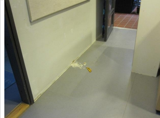
Kuva 7. Väliseinän kohta (RT5)
