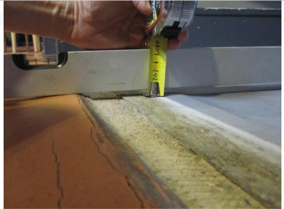
Kuva 16. Lattian painuman mittaaminen.
