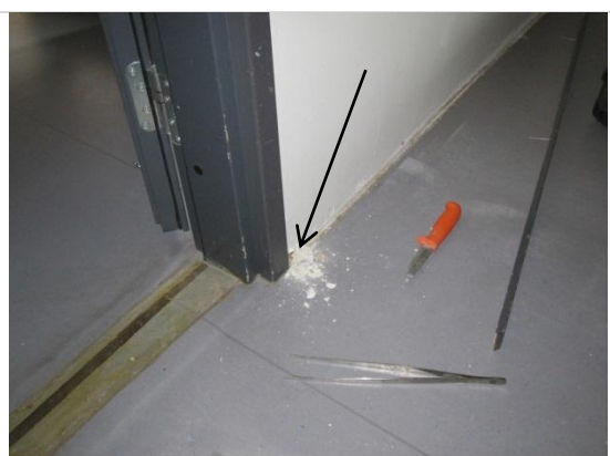
Kuva 4. Rakennearaus ja materiaalinäyte MMS 4 lattialistan takaa.
