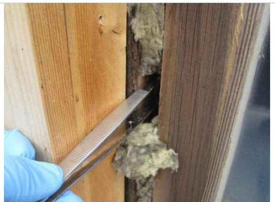
Kuva 22. Materiaalinäytteen ottokohta (MMS 7)
