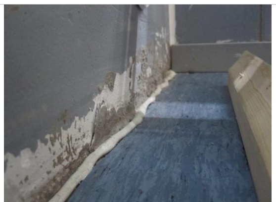
Kuva 10. Tiivistysmassan pursotusta RT 6:n kohdalla.
