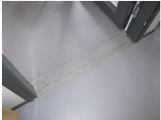
Kuva 2. Kynnys poistettu (RT1)
