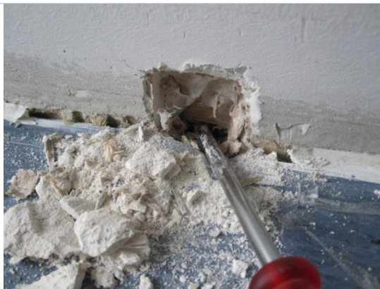
Kuva 14. RT 8, materiaalinäyte MMS 6 otettu kipsilevystä ja tiivistysmassasta.
