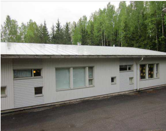
Rakennuksen ikkunat ovat alkuperäisiä puuiku-noita
