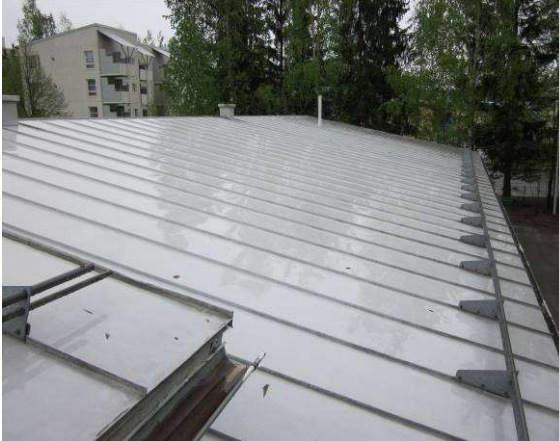
Yleiskuvaa vesikatolta, katemateriaali on konesaumattu peltikate
