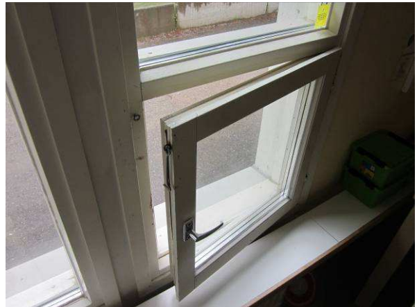
Kuvaa tuuletusikkunasta, sisäpuolella on lämpö-lasi
