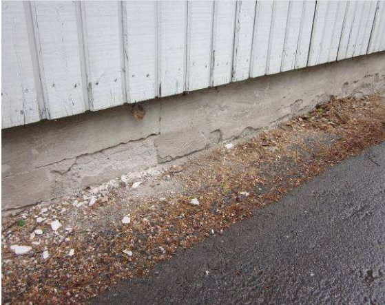
Pinnoite irtoilee harkkosokkelin pinnasta
