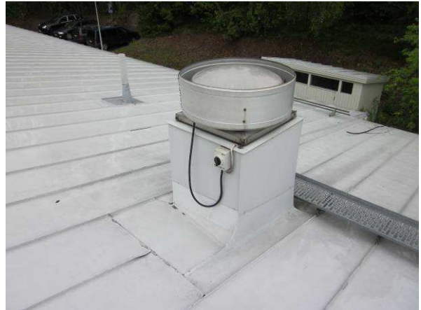
Huippumurille on metalliset kulkusillat
