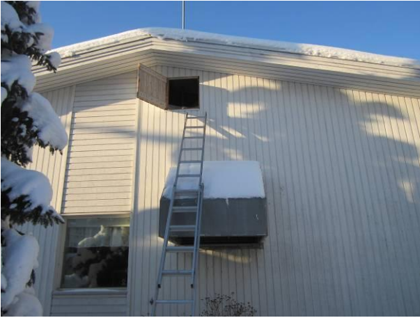
Kuva 27 Kulkuluukku teknisen tilan kohdalla. Pääsy oli hiukan hankala.
