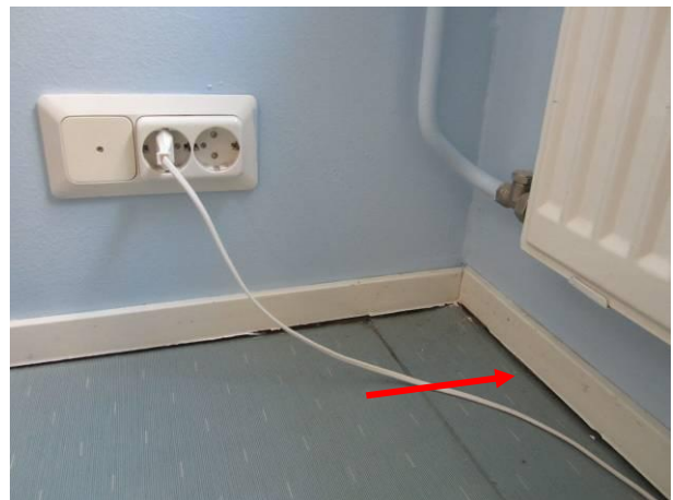
Kuva 10 Tyypillinen lattiarajan rako, jota on jo kitattu. Kyse voi olla laatan painumasta.
