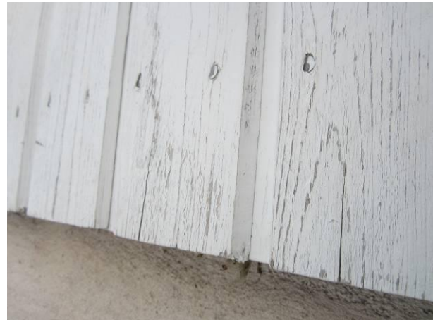
Kuva 18 Säärasitusta lautojen alapäässä.
