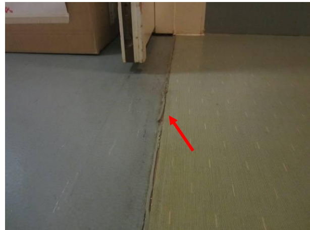
Kuva 14 Muovimaton saumaus on rikki.
