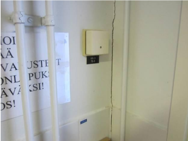
Kuva 19 Rako TK 34 ulkoseinänurkassa.
