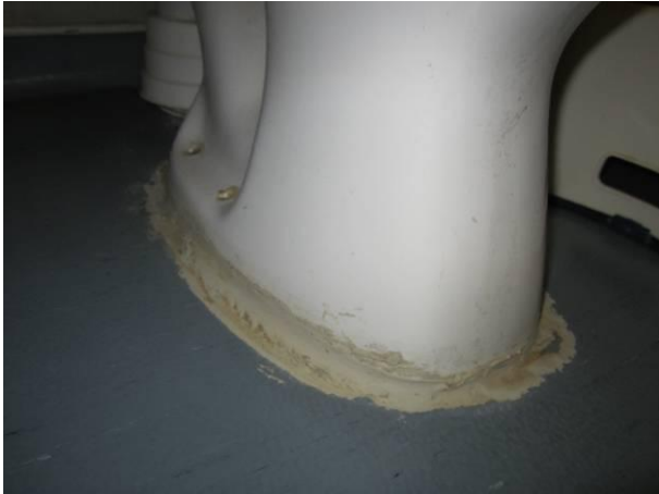
Kuva 37 Pytyn juurikittauksia Wc 38.
