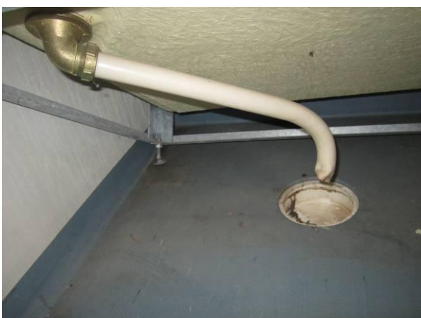
Kuva 35 Suihkualtaan alla oleva kuiva-kaivo.
