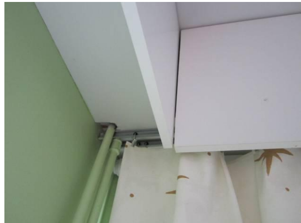
Kuva 42 Verhokoteloissa olevien lämpöputkien eristyksiä ei päästy näkemään.
