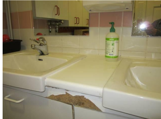
Kuva 38 Allaskaappivaurioita ET 36.
