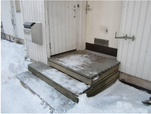
Kuva 23 Umpiovia keittiön kohdalla.
