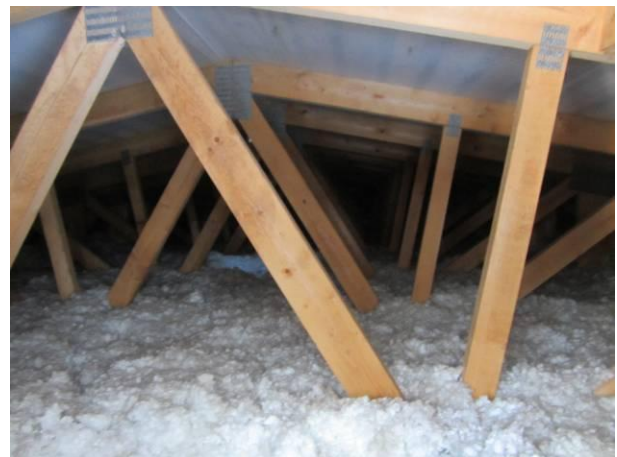
Kuva 30 Kotik. 4 yläpuolella oleva yläpohja-ontelo, jossa ei ole kulkusilloja.
