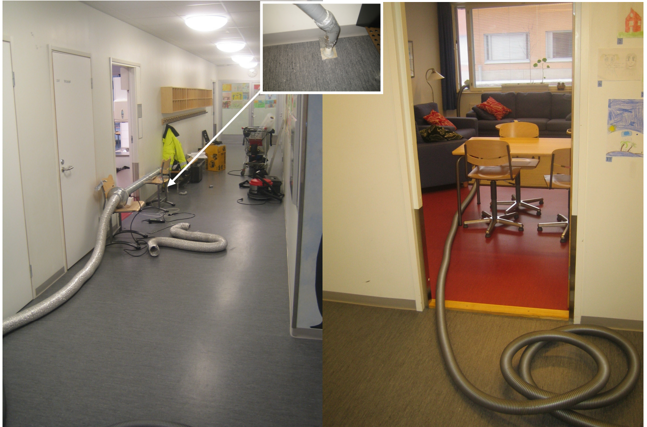
Kuvat 3 - 5. Rekolanmäen koulu. Alipaineistuskokeen alipaineistusjärjestelmä.
