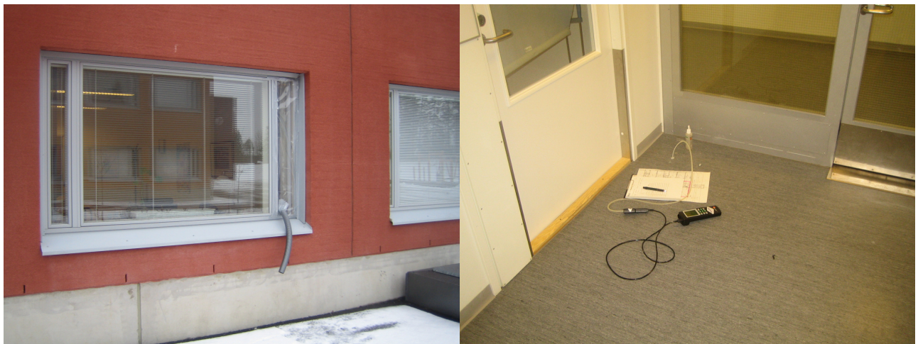
Kuvat 6 ja 7. Rekolanmäen koulun VSS:n yläpohjan alipaineistuskokeen jäteilma johdettiin ulos tilasta 2310. Kuvassa 6 alipaineistuskokeen paine-eromittaus käynnissä mittapisteessä 3.
