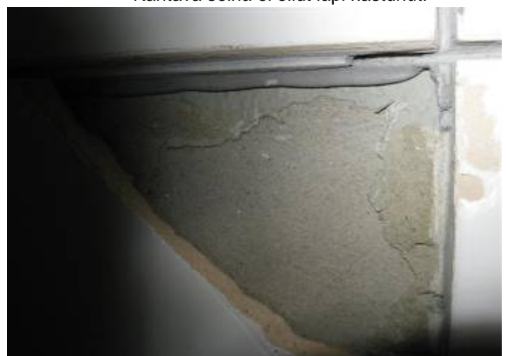
Laatoitukset ja kittaukset olivat asianmukaiset. Vedeneriste tutkittiin ja vaikutti asianmukaiselta, tosin se irtosi helposti alustastaan! Nurkan kohdalla seinässä on pystyhalkeama!
