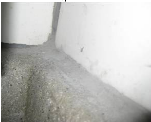
Laatoitukset ja kittaukset olivat asianmukaiset. Vedeneriste tutkittiin ja vaikutti asianmukaiselta, tosin se irtosi helposti alustastaan! Nurkan kohdalla seinässä on pystyhalkeama!
