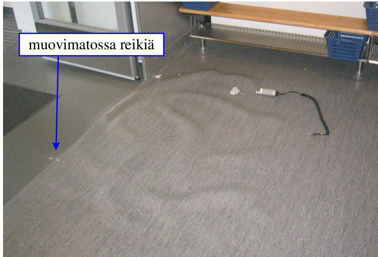
Kuva 5. Eteisen 2420 muovimatossa oli kupruja. Muovimatossa oli reikiä, jotka ovat aiheutuneet ovien lukitustapeista.
