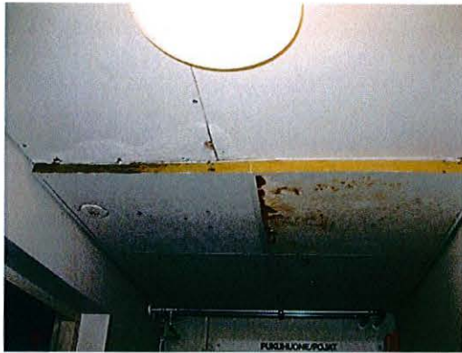
Kuva 1. Pukuhuoneiden yhdyskäytävän katto
