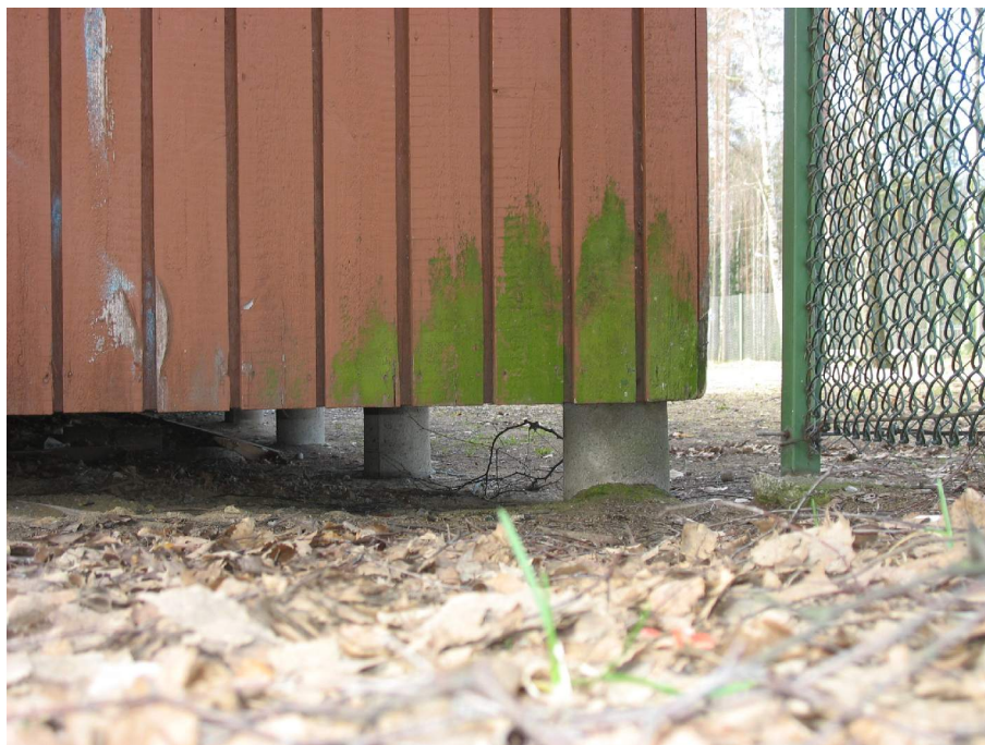
Kuva 3. Länsipääty, kaikissa nurkissa on havaittavissa kuvan kaltaista lievimmillään alkavaa lahovauriota. Vaurion syy, kuten kuvassa 2 on mainittu. Sadevesien pärskyminen julkisivuverhoukselle. Tämä on mahdollista korjata asentamalla rakennukseen syöksytorvet ja ohjaamalla sadevedet hallitusti kaupungin sadevesiverkkoon.
