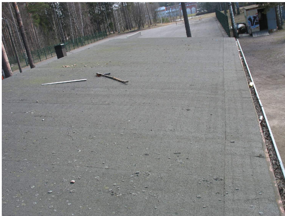
Kuva 9. Sadevesikourut on täynnä lehtiä ja havunneulasia. Kourut on hyvä tyhjentää kerran vuodessa sinne kertyvästä roskasta.
