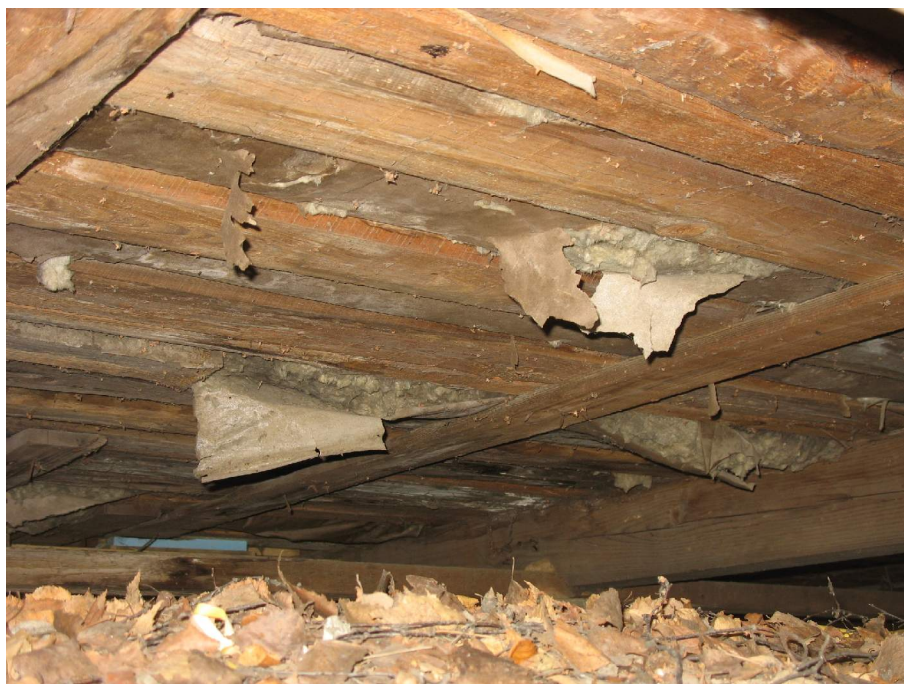
Kuva 3. Länsipääty, kaikissa nurkissa on havaittavissa kuvan kaltaista lievimmillään alkavaa lahovauriota. Vaurion syy, kuten kuvassa 2 on mainittu. Sadevesien pärskyminen julkisivuverhoukselle. Tämä on mahdollista korjata asentamalla rakennukseen syöksytorvet ja ohjaamalla sadevedet hallitusti kaupungin sadevesiverkkoon.
