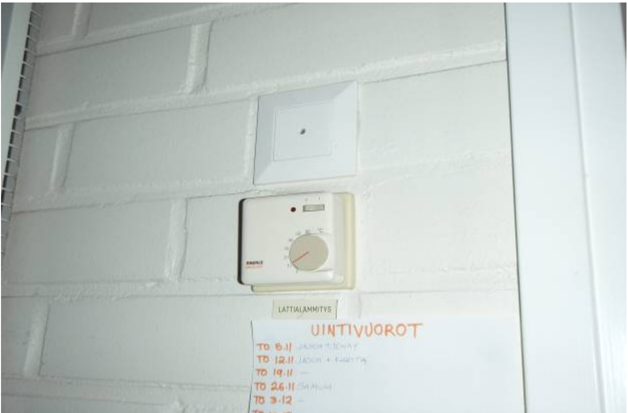
S-KUVA 10. Vesileikkitalan lattialämmityksen termostaatti
