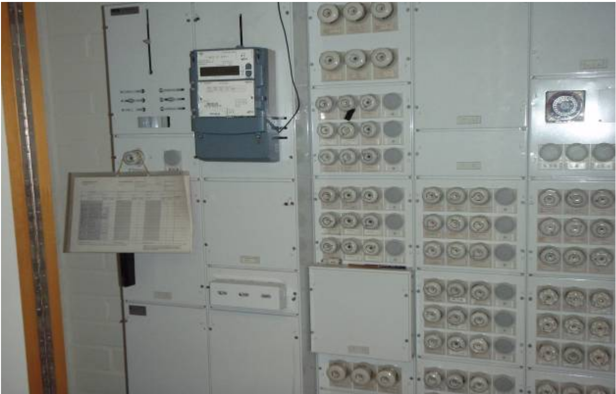
S-KUVA 3. Sähköpääkeskus
