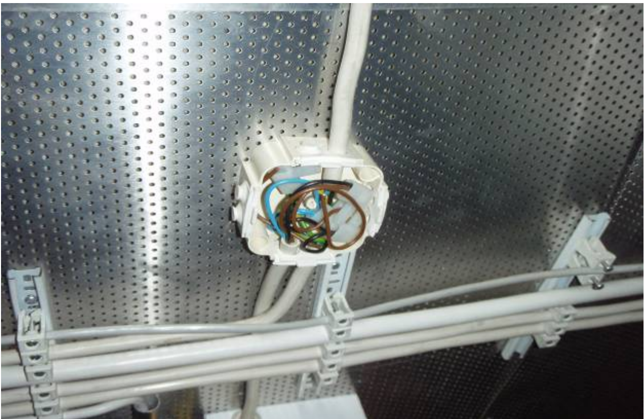
S-KUVA 4. Jakorasiasta puuttuu kansi
