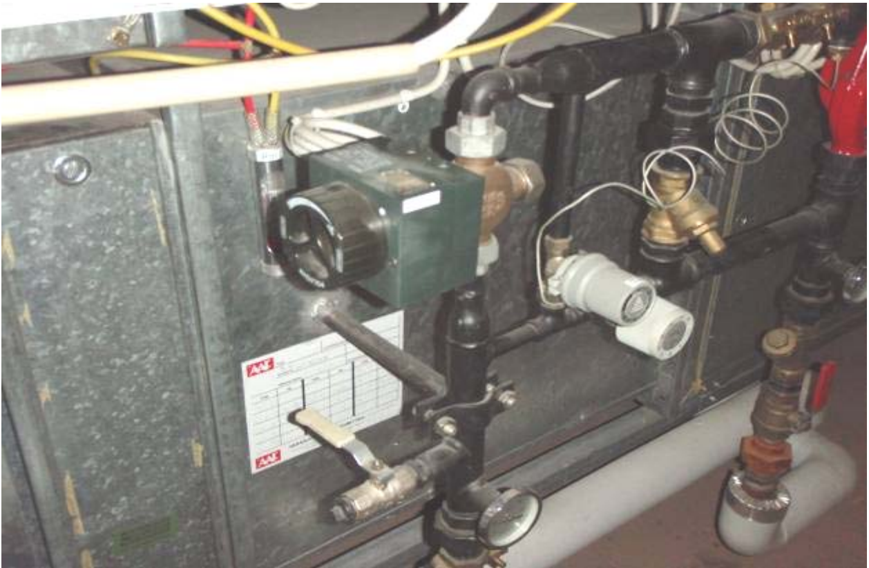
S-KUVA 15. IV- koneikon moottoriventtiili
