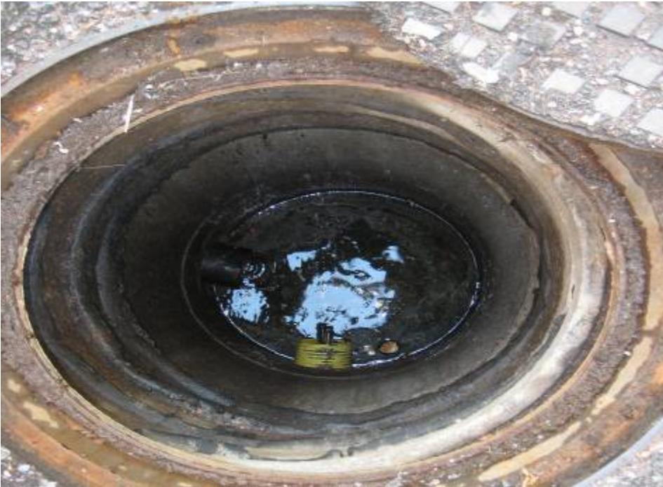
RAK-KUVA 5: Salaojarakenteen tarkastuskaivoista ei tehty havaintoja mitkä viittaisivat järjestelmän toimimattomuuteen.
