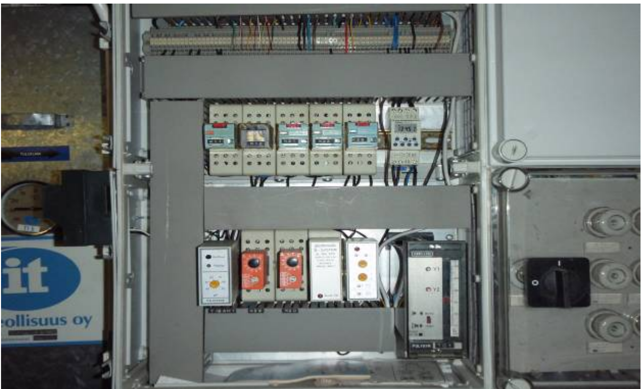
S-KUVA 14. IV- koneikon yksikkösäädin
