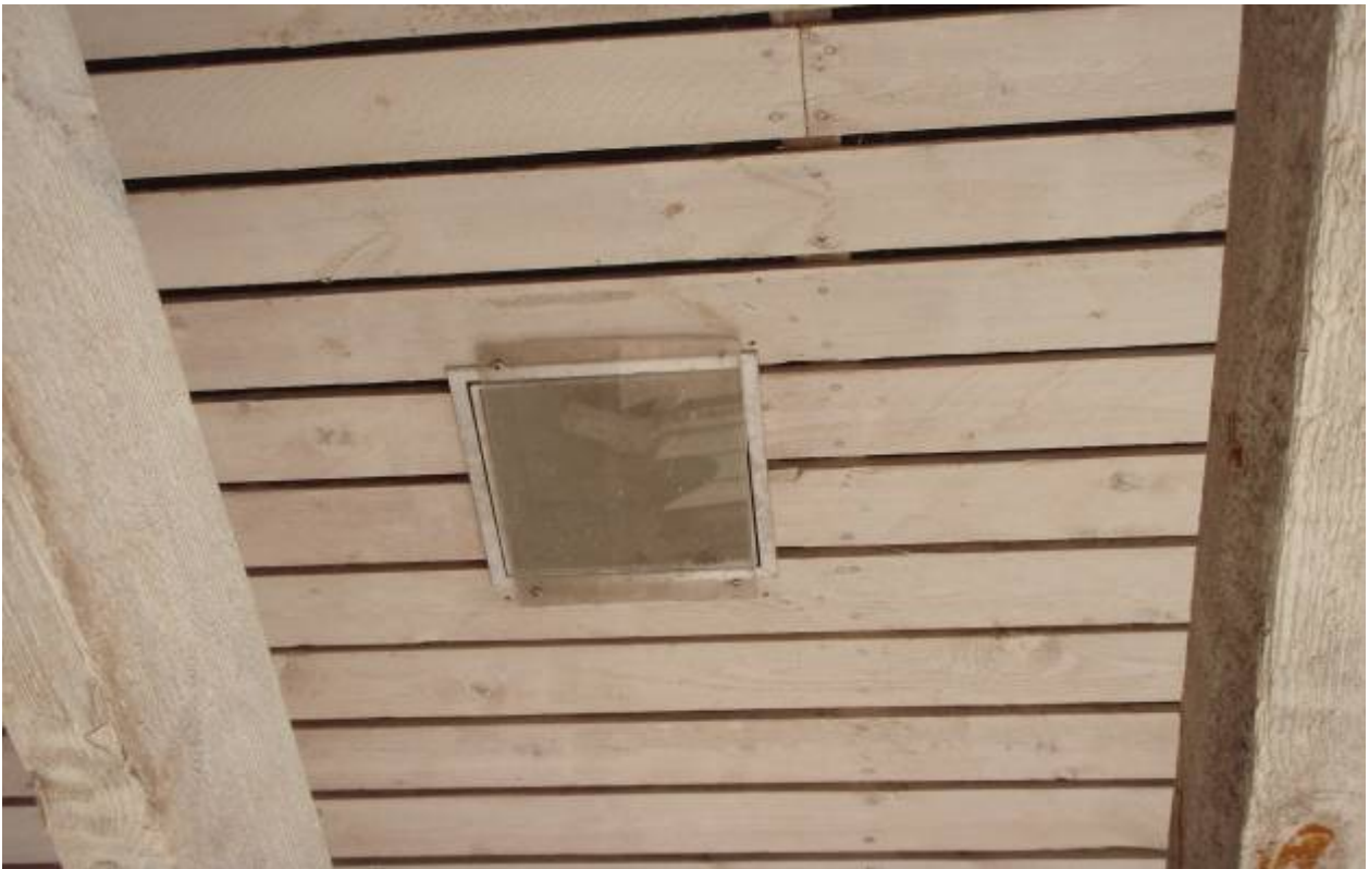
S-KUVA 1. Sisäänkäynnin valaistus
