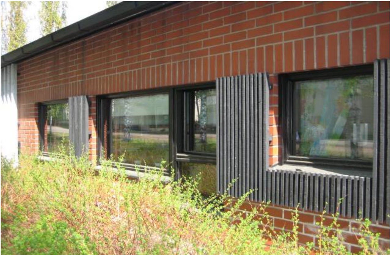
RAK-KUVA 7: Yleiskuva ikkunarakenteista.
