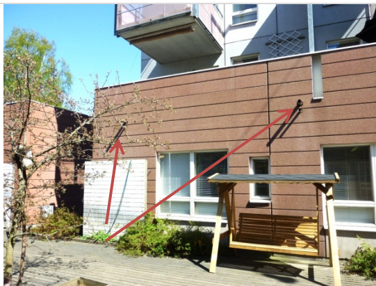
Kuva 12. Toisen kerroksen parveke ja vedenpoistoputket.
