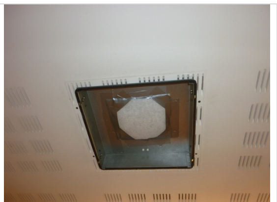
Kuva 2. Tuloilman kuitupitoisuuden mittausruokasalin tuloilmaventtiilistä.
