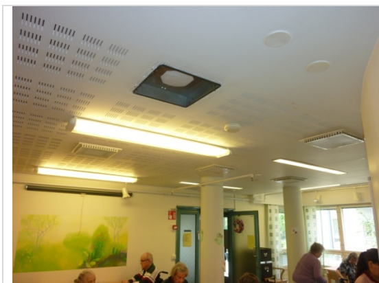
Kuva 1. Tuloilman kuitupitoisuus mitattiin ruokasalin tuloilmaventtiilistä.
