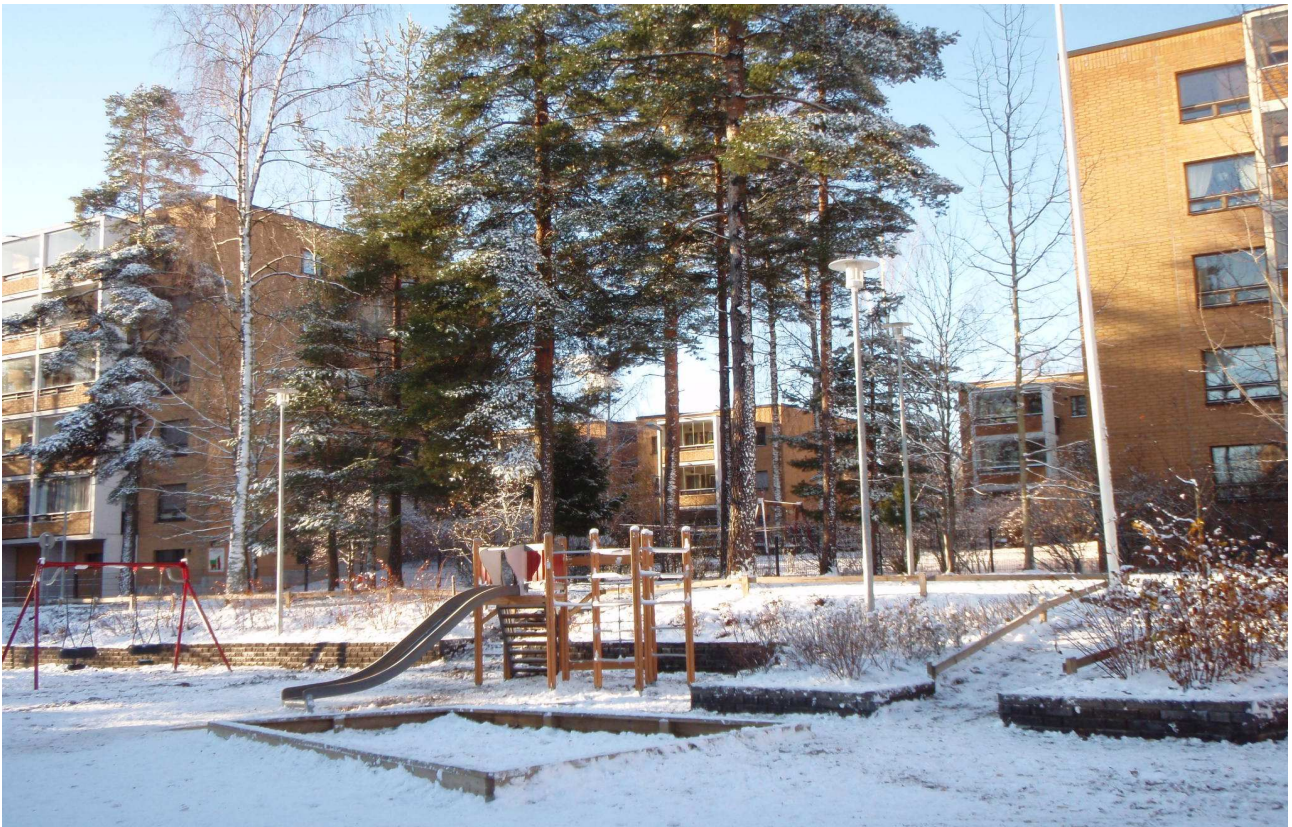
S- kuva 2. Pylväsvalaisimet.
