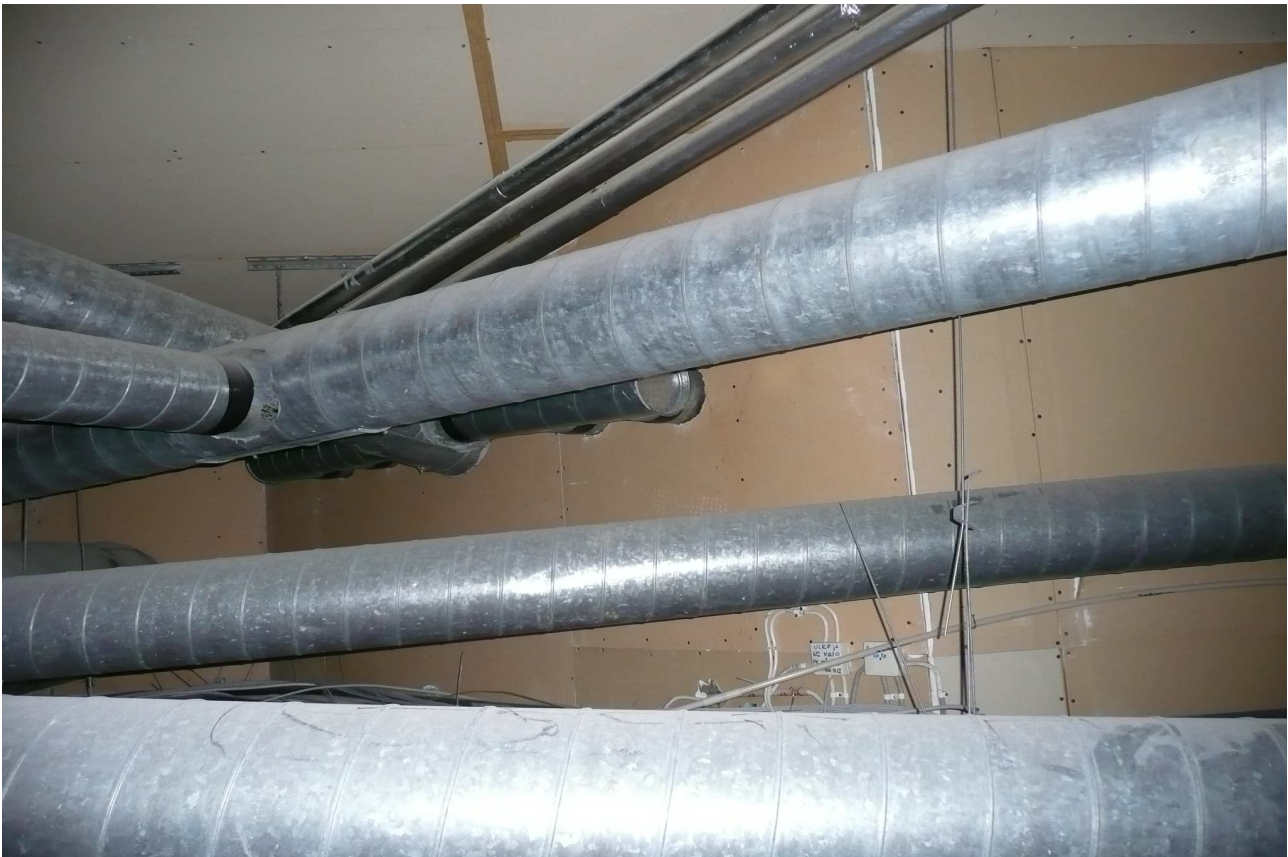
RAK- kuva 5. Yläpohjarakenteita pääsi tarkastelemaan ainoastaan käytävältä.
