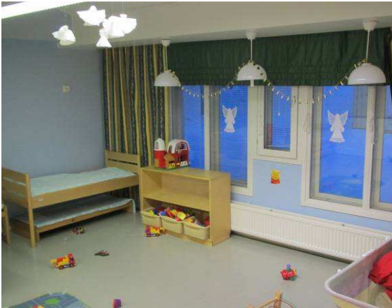
Ryhmätiloissa ei havaittu kohonneita kosteuspitoisuuksia
