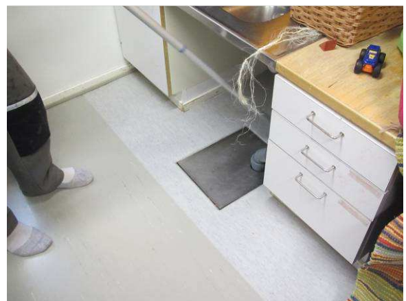
Vesileikkihuoneiden kaivot on tukittu, lattiamattoja on uusittu paikoin
