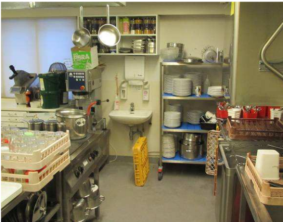
Keittiössä on massalattia, kohonneita kosteuspitoisuuksia ei havaittu
