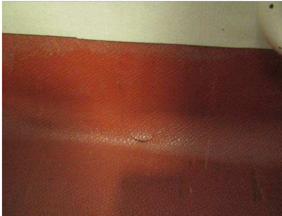
Alkuperäiset lattiamatot ovat ikääntyneitä ja kuluneita, wc-tilan mattonostossa reikä
