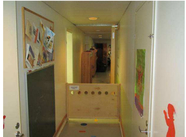
Käytävätiloissa ei havaittu kohonneita kosteuspitoisuuksia
