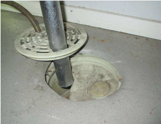
IV- konehuoneen lattiakaivo, muovimatto on kiristysrenkaan päällä
