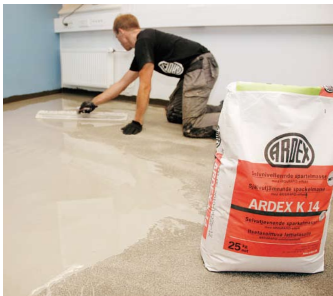
ARDEX K 14 on matala-alkalinen M1-luokiteltu tasoite, jolla saadaan helposti valmis pinta päällysteelle.
