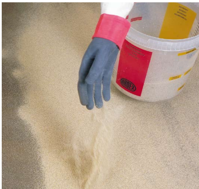
ARDEX EP 2000 on M1-luokiteltu höyrynsulku. Toiseen levityskertaan levitetään hiekka kauttaaltaan peittävästi .
