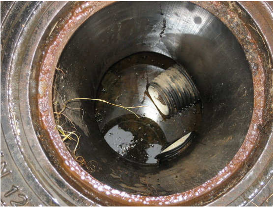
Kuva 11 Salaojien tarkastuskaivojen kansi-/säätöosat painavat salaojaputkia.
