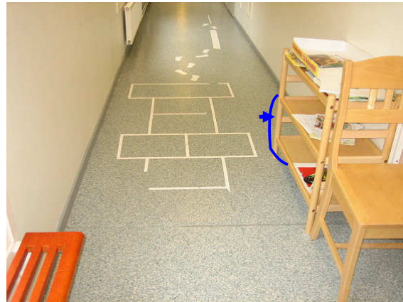
Kuva 6 Käytävän lattiassa havaittiin pienellä alueella vertailuarvoa korkeampia lukemia.
