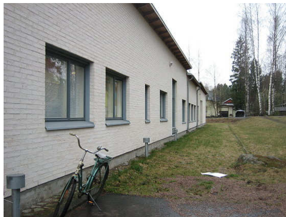
Kuva 7 A-osan takapihaa. Alustatilan tuuletusputkia.
