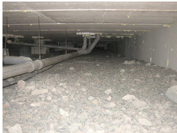
Kuva 2 Alustatilassa on karkeaa sepeliä.
