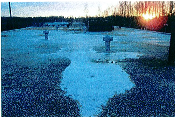
Kuva 17 Yleisnäkymä vesikatolta, jossa oli hyvin loivat kallistukset. Etualalla olevan jään alla oli toinen kattokaivoista. Keskellä näkyy matalia tuuletusventtiileitä
