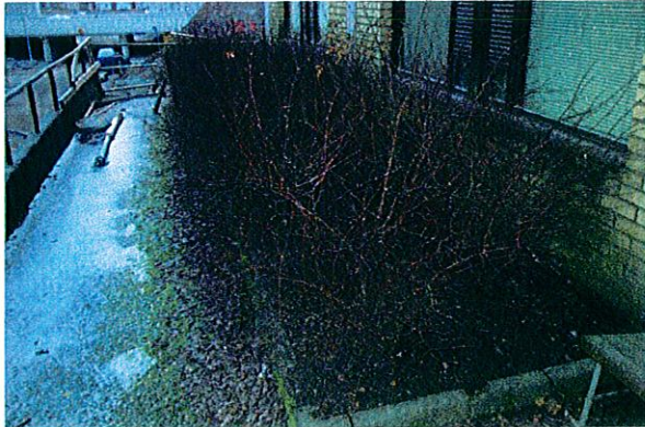
Kuva 3 Pohjoisivulla maanpinta on liian korkealla ja pensaita liian lähellä
