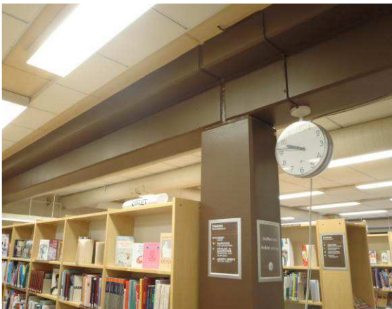
Runkorakenteina oli käytetty pääasiassa elementtivalmisteista teräsbetonia.
