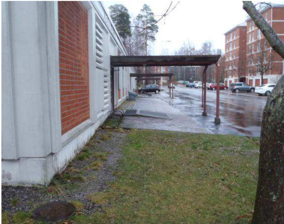
Kallistukset rakennuksen ympärillä ovat riittävät. Vedet ohjautuvat pois rakennuksen läheisyydestä.
