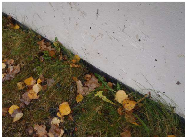
Sokkelissa on osin ulkopuolinen kosteuseristys.
