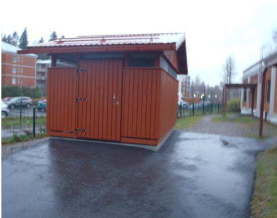
Jätetila on uusittu.
