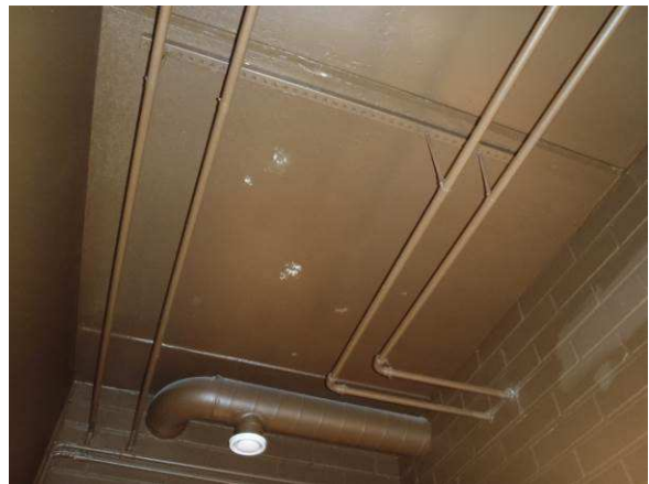
Yläpohjan ontelolaatta rakenteita.
