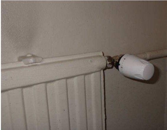
Termostaattinen patteriventtiili.
