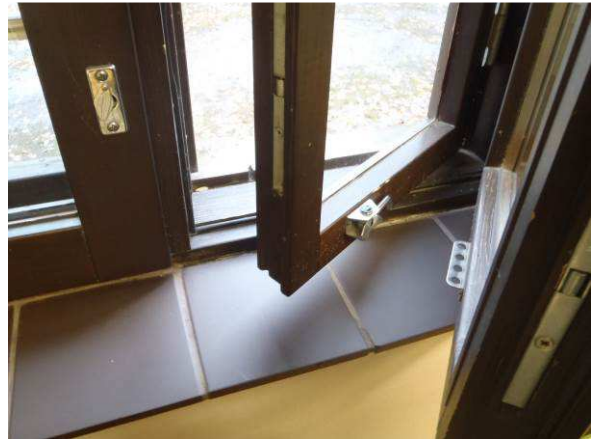
Avattavat ikkunat ovat kunnossa.
