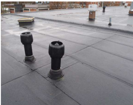
Läpivienneissä ei havaittu puutteita. Kuvassa vesikaton alipaine tuuletusputket.
