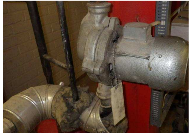
Paisunta-astia on lämmönsiirrinpaketin ikäinen. Lämmitysverkoston kiertovesipumppu.
