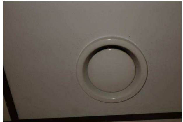
Poistoilmaventtiili.
