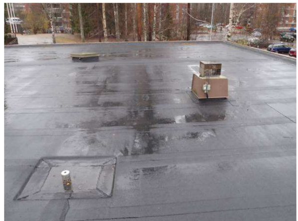
Katolla ei havaittu merkittävää veden lammikoitumista.
