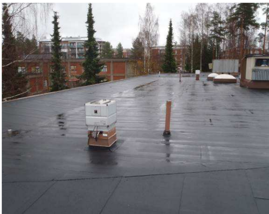
Vesikate on hyvässä kunnossa.
