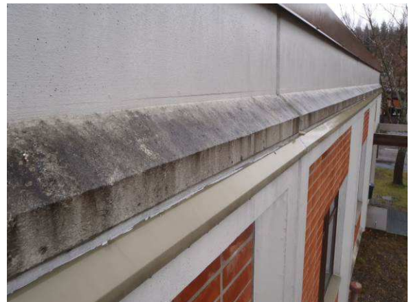
Julkisivua räystäään kohdalta. Elementtien väliin on lisätty vesipelti.
