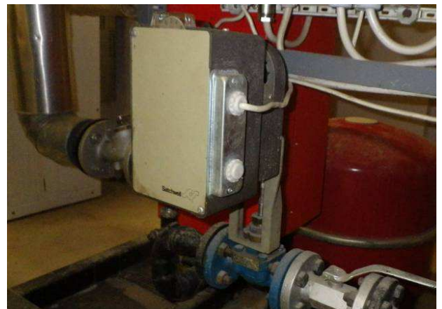
Alkuperäinen säätöventtiili (Satchwell)
