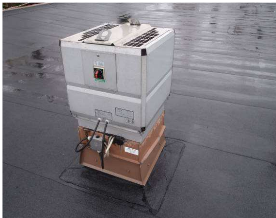
Uusittu huippuimuri.
