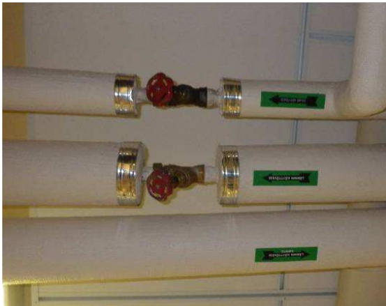
Käyttövesiverkoston sulkuventtiilejä.
