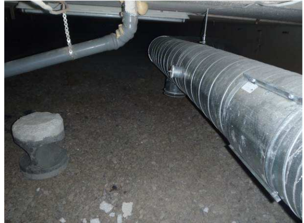
Olosuhteet alapohjassa ovat kunnossa. Pohjalla on sepelikerros.
