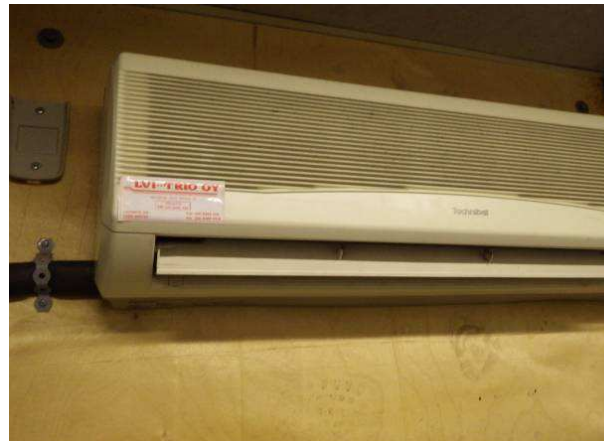
Kompressorihuoneen jäähdytin.
