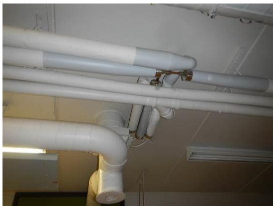
Kuva 11. Uusittuja käyttövesiputkiosuuksia opetustiloissa.
