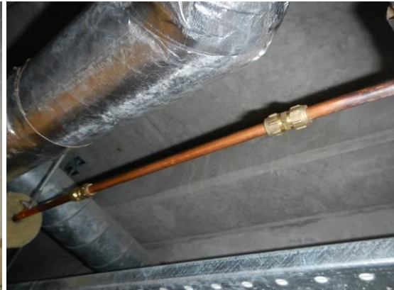
Kuva 10. Uusittua lämpimän veden kierto-johtoa alakaton takana.
