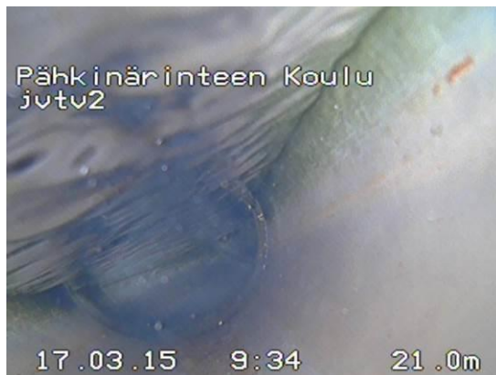
Kuva 14. Painumasta johtuvaa vesitäyttöä 2 metrin matkalla ennen rasvanerotinta.
