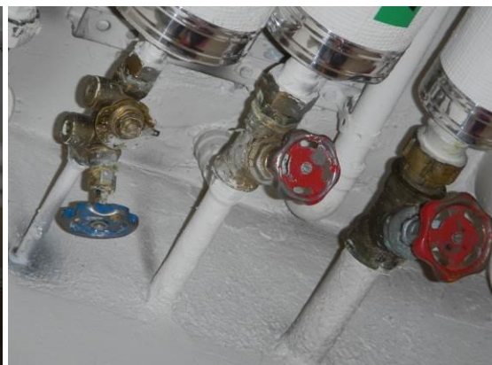
Kuva 12. Käyttövesiverkoston alkuperäisiä vinoistukkaventtiileitä.
