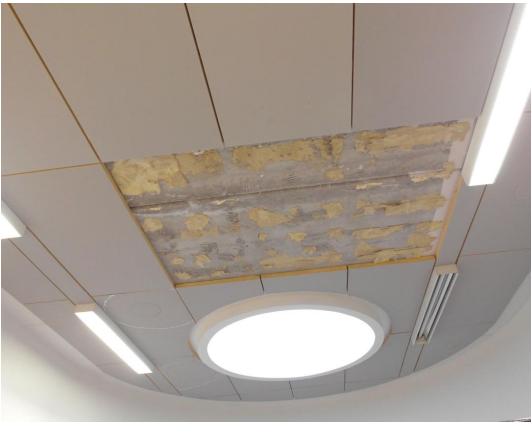
Kuvat 1,2 . Aulaan 104 liittyvän portaan katossa oli merkkejä kosteusvauriosta. vaurioituneet levyt uusitaan. Aulan alueella tuulikaapin päädyssä on vähäinen jälki ontelolaatan saumasta vuotaneesta
