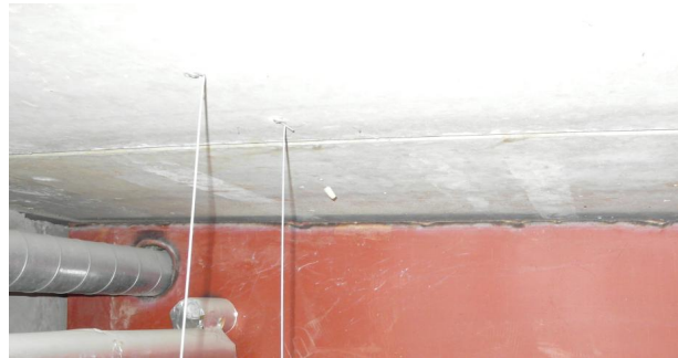
Kuvat 1,2 . Aulaan 104 liittyvän portaan katossa oli merkkejä kosteusvauriosta. vaurioituneet levyt uusitaan. Aulan alueella tuulikaapin päädyssä on vähäinen jälki ontelolaatan saumasta vuotaneesta
