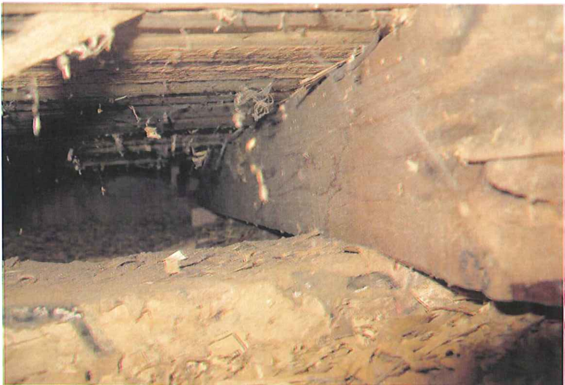
Kuva 6. Välipohjan puurakenteet ovat kuivia ja tervettä puuta.
