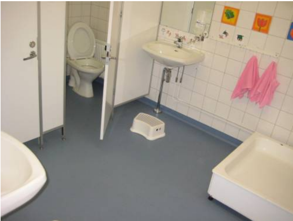
RAK-KUVA 13: Märkätilojen rakenteet arvioitiin rakenteellisesta olevan suhteellisen hyväkuntoisia / olevan rakenteellisesti teknistä käyttöikää jäljellä tulevan 10-vuoden tarkastelujakson ajan, mikäli niiden rakenteisiin kohdistetaan tavanomaisia ylläpitotoimenpiteitä.
