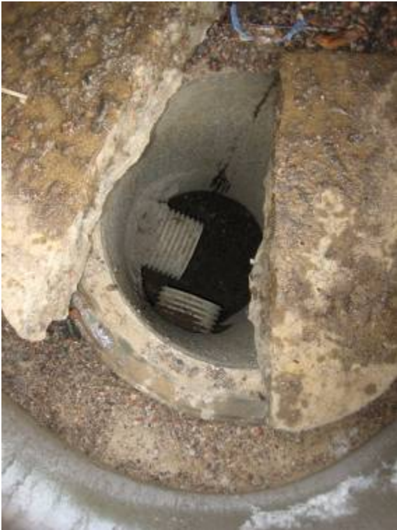
RAK-KUVA 7: Rakennuksen rakenteista / salaojajärjestelmän tarkastuskaivoista ei tehty havaintoja järjestelmän toimimattomuudesta / välittömästä kunnostustarpeesta.
