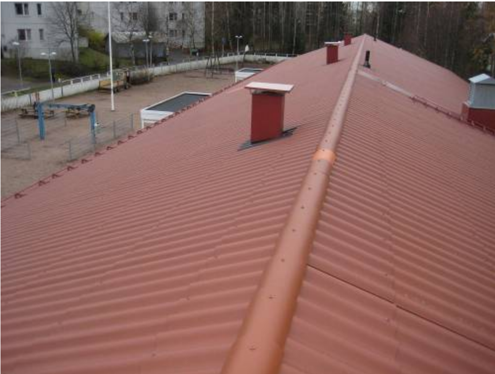
RAK-KUVA 10: Vesikaterakenteet on kunnostettu viimevuosien aikana.
