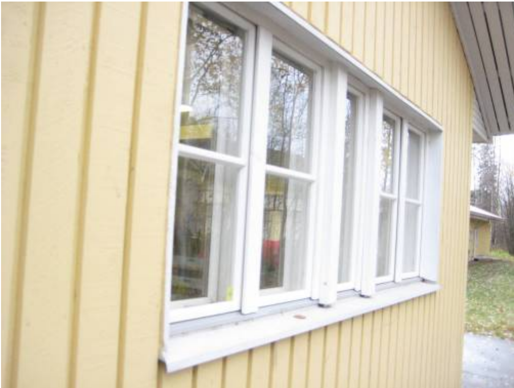
RAK-KUVA 8: Ikkunarakenteet arvioitiin olevan tyydyttävässä kunnossa.
