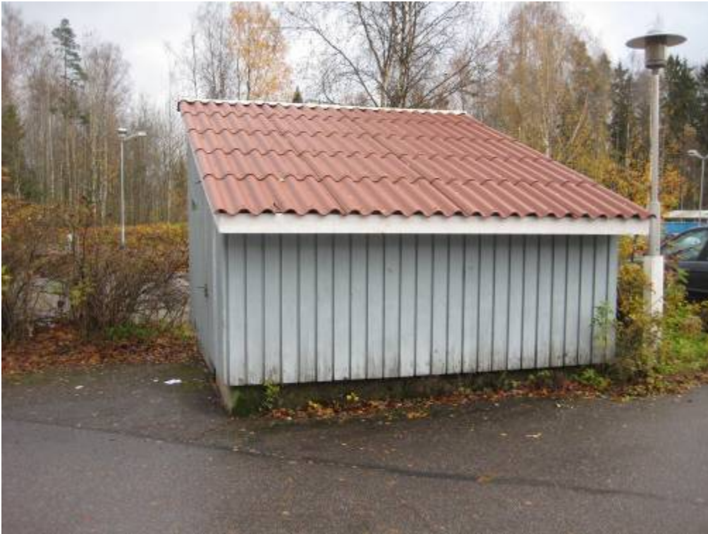
RAK-KUVA 5: Kiinteistöön liittyvä jätehuoltokatos.
