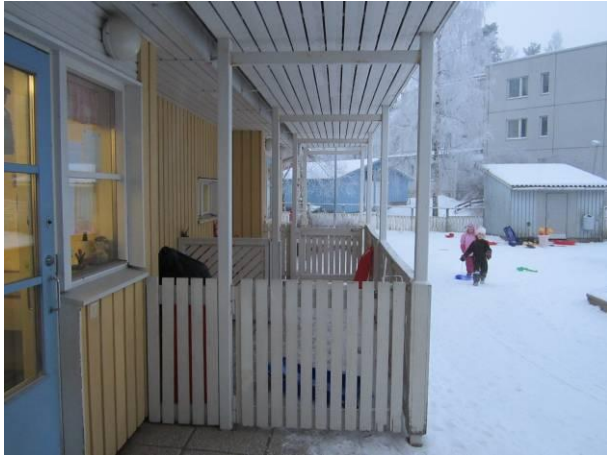
Kuva 21 Tasakattoisia sisäänkäyntikatoksia sisäpihalla.
