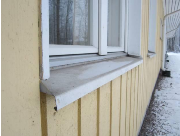
Kuva 13 Loiva vesipelti ulottuu riittävän pitkälle.
