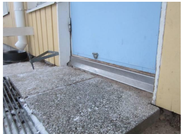
Kuva 20 Potkupelti puuttuu
