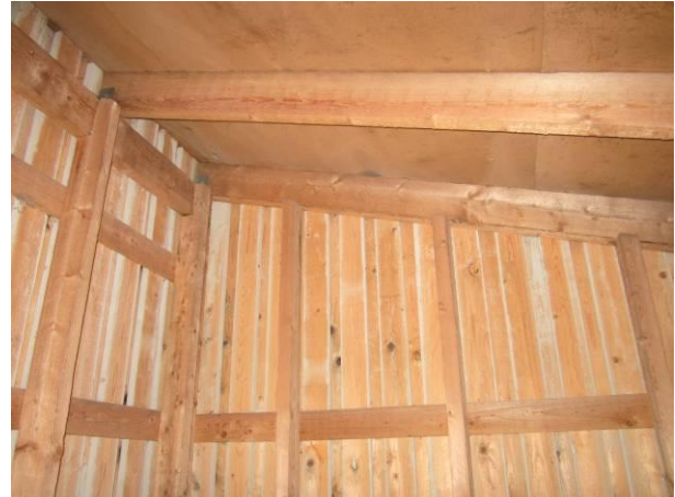
Kuva 4 Pihavarstojen sisäpinnat ovat vielä kunnossa.
