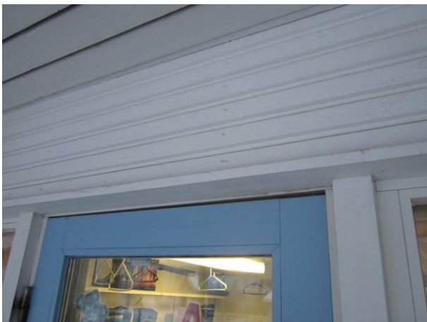
Kuva 19 Ovirunko on antanut myöten.
