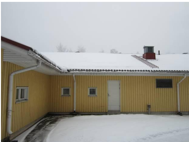
Kuva 5 Kaikilla sivulla on kattosadevesien viemärinti.
