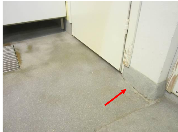
Kuva 28 Halkeilua juurinoston ja lattian liittymässä.
