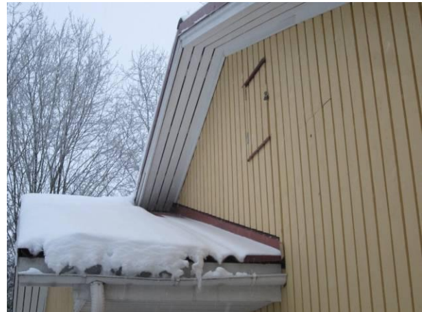
Kuva 24 Tasoeron juuripellitykset ovat ok.
