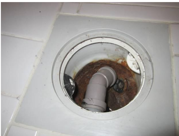
Kuva 33 Vanha valurautainen lattiakaivo.
