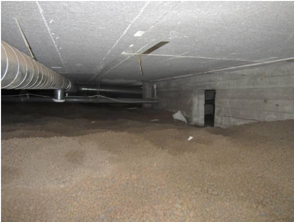
Kuva 7 Alustatila ja tuuletuskanavia.
