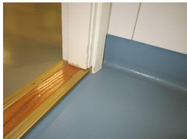
Kuva 32 Uusitulta vaikuttava tammikynnys ja muovimaton juurinosto.
