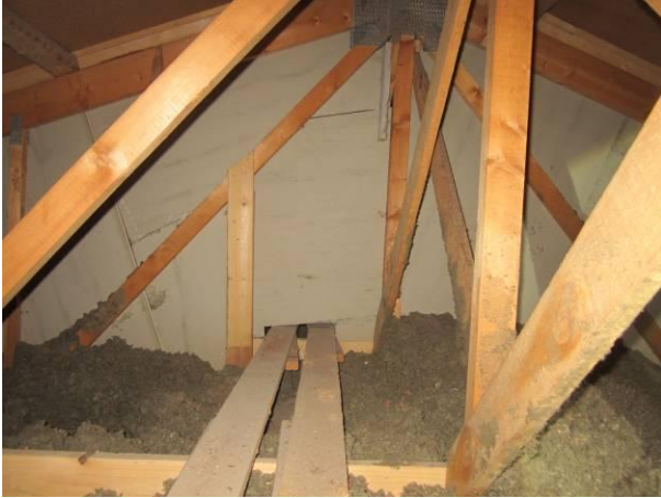
Kuva 25 Kulkusilta ja palokatko.
