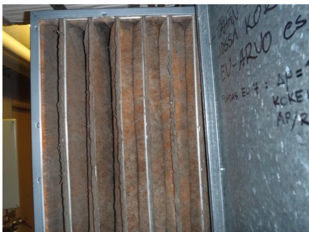
Kuva 3 Likainen tuloilmasuodatin.
