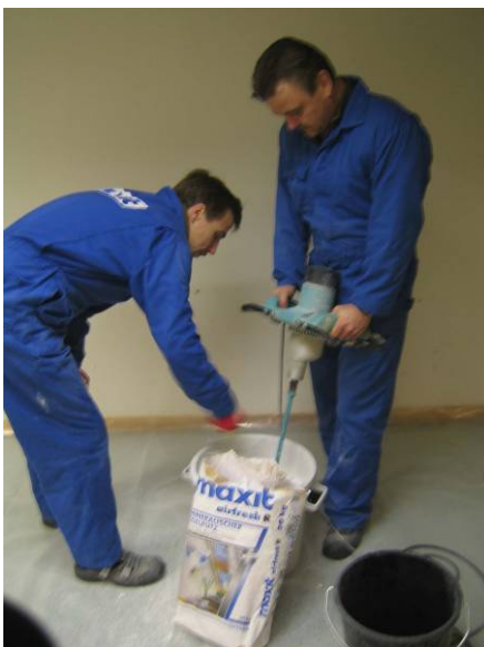
Kolme seinää pinnoitettiin maxit airfresh R:llä (2 mm)
