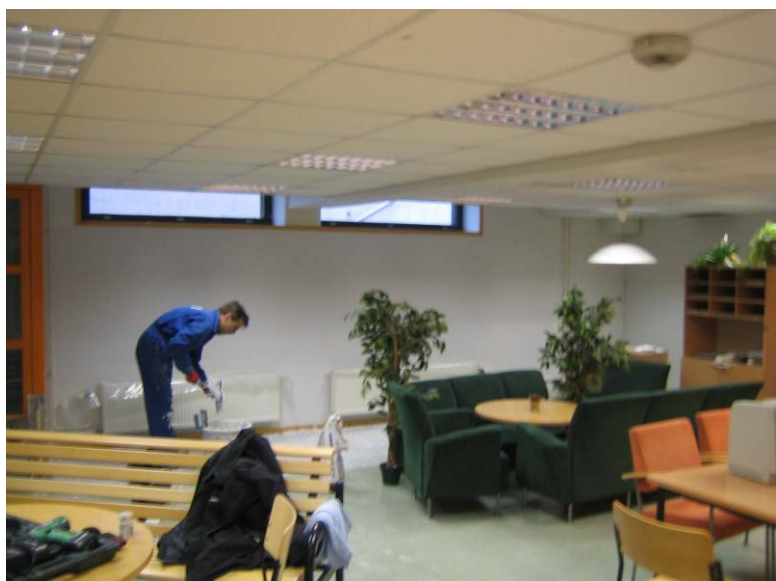
Kolme seinää pinnoitettiin maxit airfresh R:llä (2 mm)
