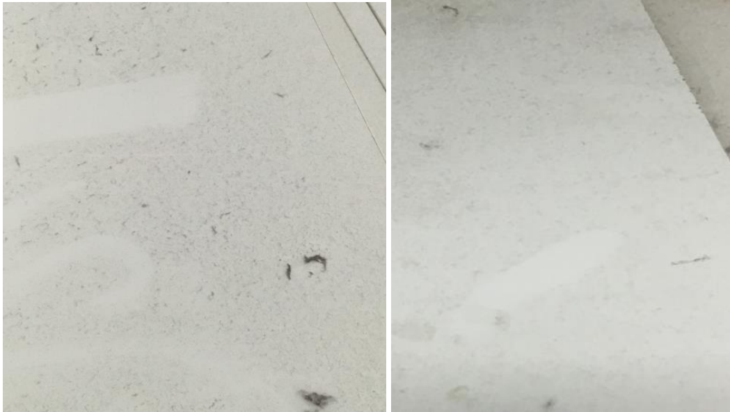
Kuva 6. Kaappien päällä paikoin runsaasti pölyä. Kuva vasemmalla kotitalousluokasta (1049) ja oikealla luokasta 2013. Osa pölystä oli tummaa, eikä vaikuttanut normaalilta huonepölyltä.
