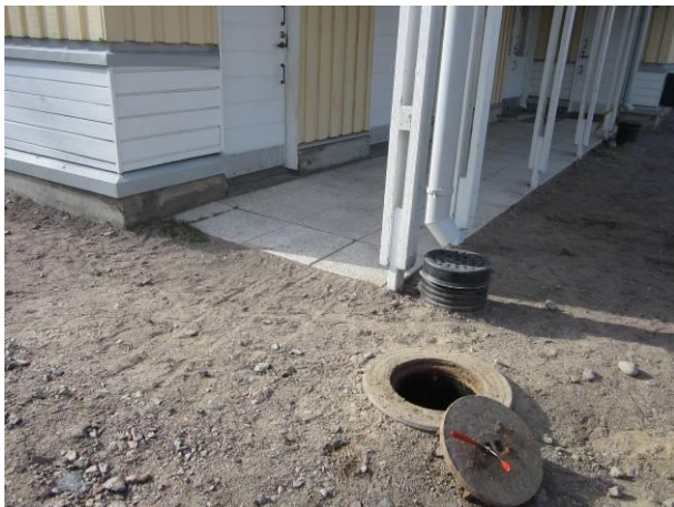
Kuva 1 Eteläpäädyn kaakkoiskulman so-kaivo
