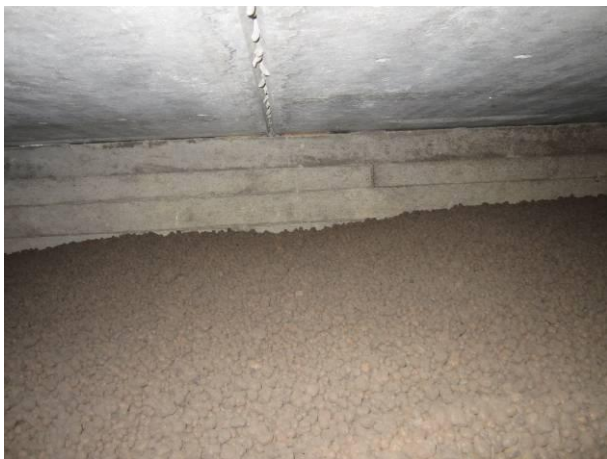
Kuva 9 Siistit betonipinnat ja kuiva kevytsora.
