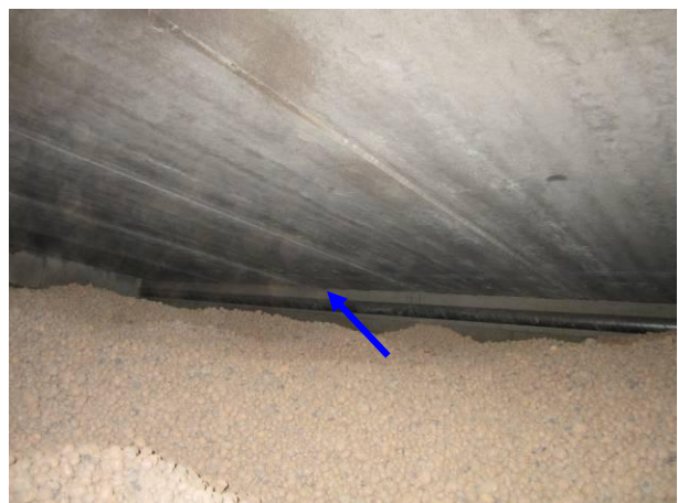
Kuva 16 Alustatilaa leikki- ja lepohuoneen 47 alla ja IV-kanavaa.
