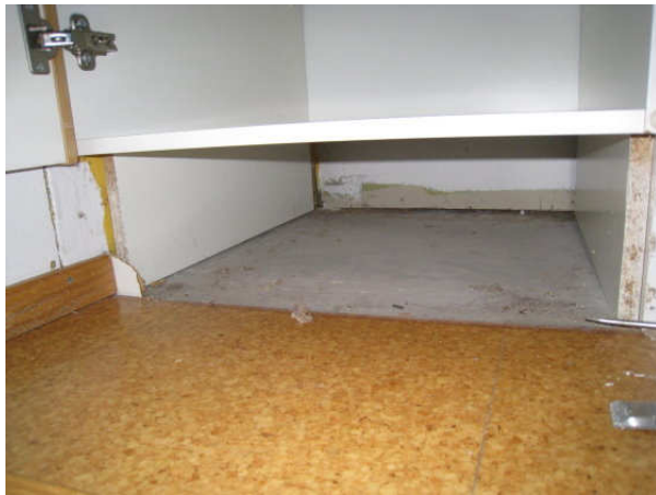
Kuva 9 Tutkittu komeron alusta eteisessä 105, johon tehtiin PR5 -mittaus.
