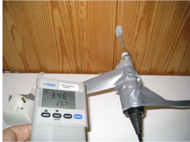
Kuva 8 Porareikämittaus PR4yläpohjan eristeti- lasta (20,7 °C, 35 % RH, 6,3 g/ m 3 on kuiva).
