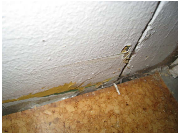
Kuva 10 Ulkoseinän puurakenne jatkuu lattiapi- nan alapuolelle pohjalaattaan asti.
