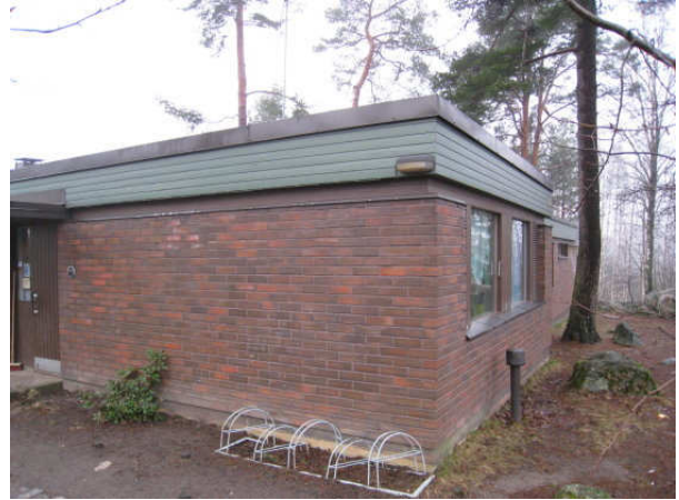
Kuva 14 Yleiskuva pohjoiskulmalta, jossa maanpinnat ovat tasaiset ja korkeus on lähellä pohjalaatan yläpinnan tasoa. Sokkelin vieressä on humusmaata.
