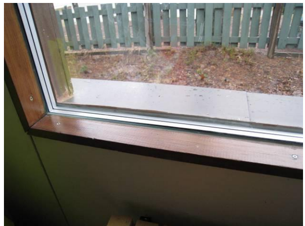
Kuva 6 Laselementin ja vesipellityksen tiiviys on vain kitin varassa.
