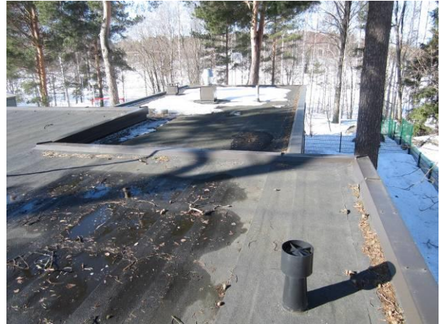
Kuva 8 Vesikattoa kuvattuna eteistilan kohdalta
