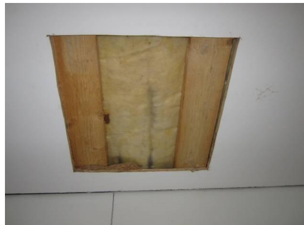
Kuva 34 AV4C -avaus kattoon.
