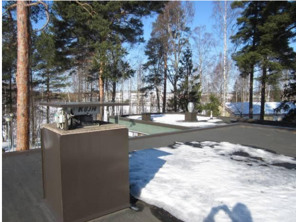
Kuva 7 Vesikattoa kuvattuna takahuoneen kohdalta.
