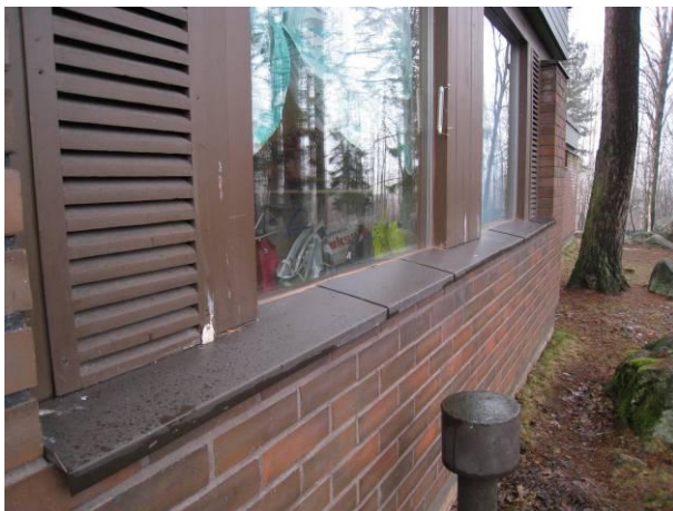
Kuva 5 Loivat ikkunavesipellit v. 2008
