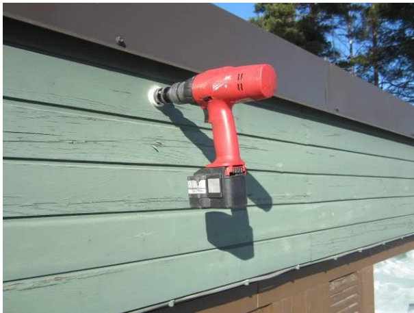
Kuva 9 Tähtystysreikä räystäään otsaan
