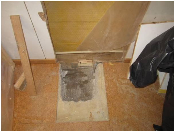
Kuva 27 AV3A -rakenneavaus/ eteinen 105
