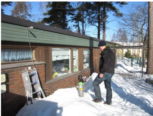
Kuva 13 Merkkiainekaasun annostelua yläpohjaonteloon.
