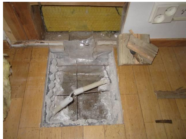
Kuva 32 AV4A -kohdalta otettiin MAT4. Laatasta on sähköjohtoja suojaputkessa.
