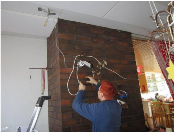
Kuva 22 Paine-eroanturin asennus takkahuoneen 122 ja yläpohjan väliin.
