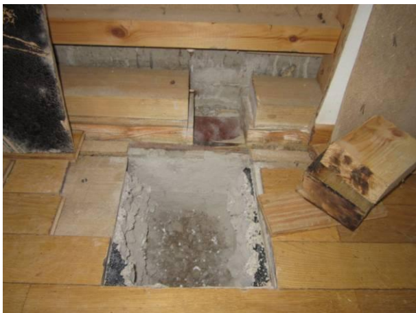
Kuva 33 AV4B –avaus väliseinäliittymään.
