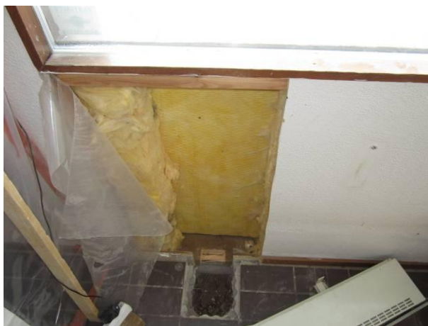
Kuva 25 AV2 -rakenneavaus/ takkatupa 122.
