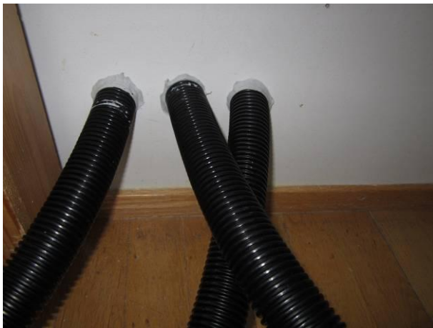
Kuva 18 Imuputket tiivistettyinä seinässä.
