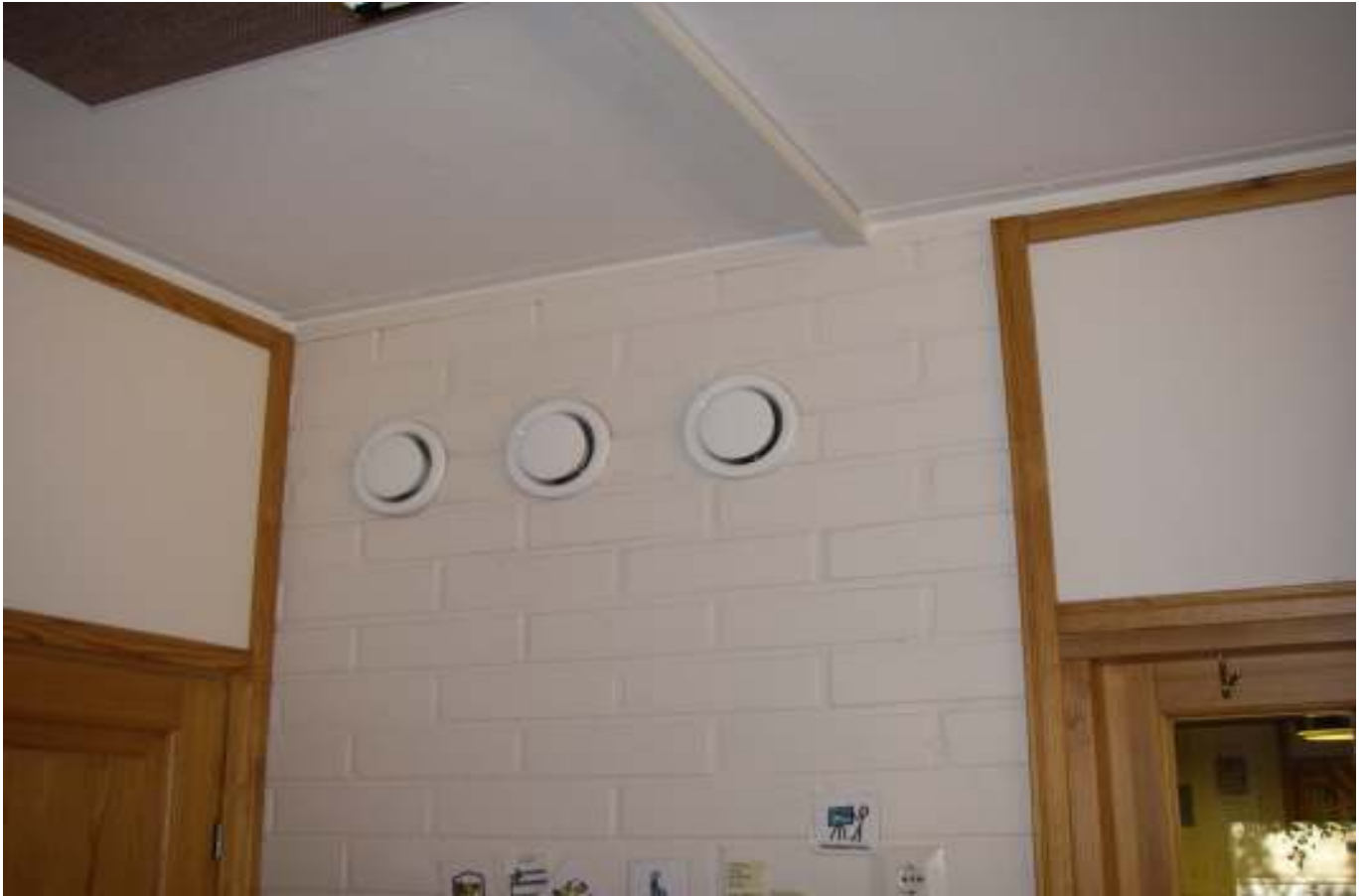
KUVA 17. Yleiskuva poistoilmaventtiileistä.
