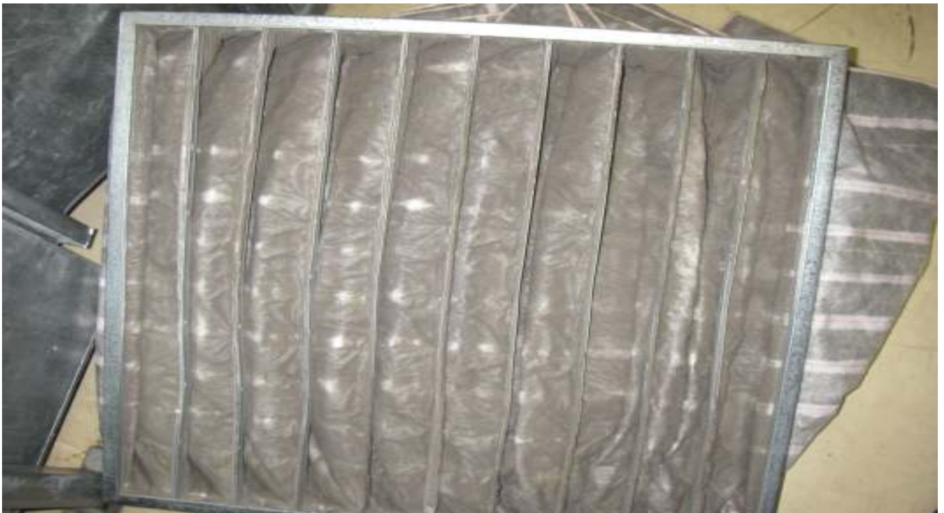
KUVA 2. Yleiskuva tuloilmasuodattimesta.
