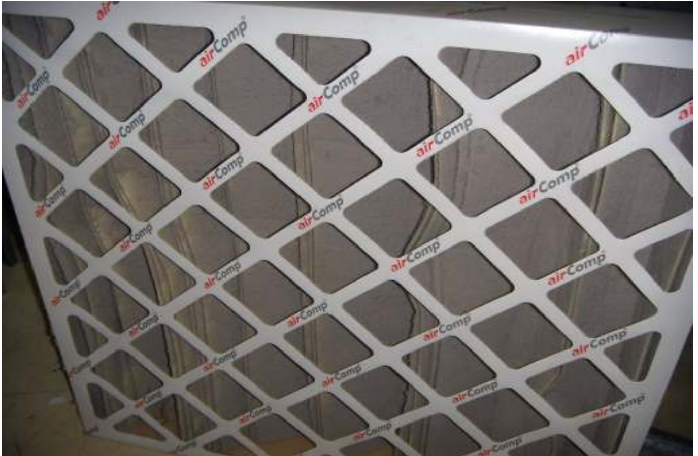
KUVA 7. Yleiskuva poistoilmasuodattimesta.
