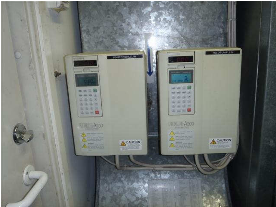
Kuva3. Tulo- ja poistoilmakoneiden tehoa ohjaavat taajuusmuuntajat.
