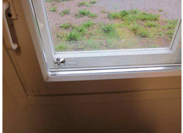
Kuvaa tuuletusikkunasta, sisäpuolella on lämpölasia
