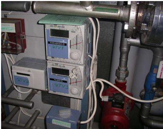
Lämmönsiirrinpaketti.
