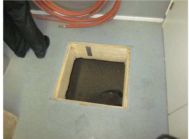
Alapohjatilaan on kulku lämmönjakohuoneesta kulkuluukun kautta
