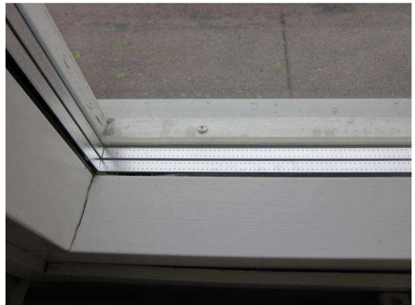
Suuremmat ikkunat ovat lämpölasielementtejä
