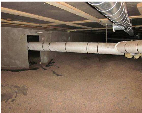
Alapohjatila on peruskorjattu ja sinne on tehty ilmanvaihto
