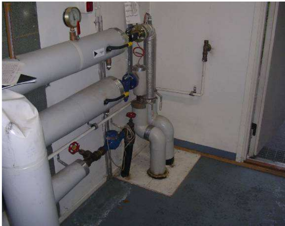
Kiinteistön vesimittari.
