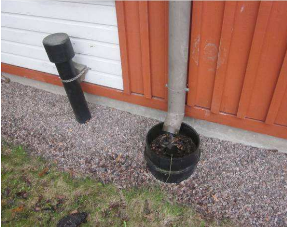
Betonisokkelit ovat tyydyttävässä kunnossa
