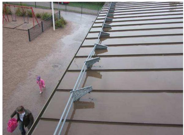
LumiESTEIDEN kiinnikkeet ovat irronneet katteesta lumikuorman vaikutuksesta
