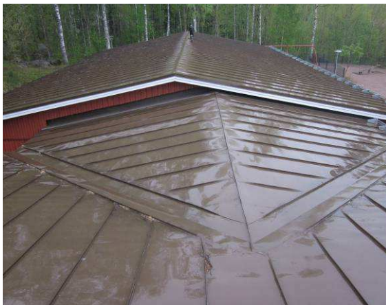
Yleiskuvaa vesikatolta, katemateriaali on konesaumattu peltikate
