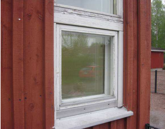
Rakennuksen ikkunat ovat alkuperäisiä puuikkunoita
