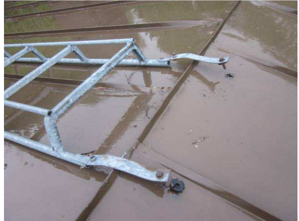
Lapetikkaiden kiinnikkeet niin ikään irti
