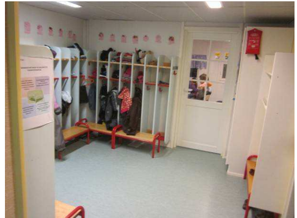
Käytävätiloissa ei havaittu kohonneita kosteuspitoisuuksia
