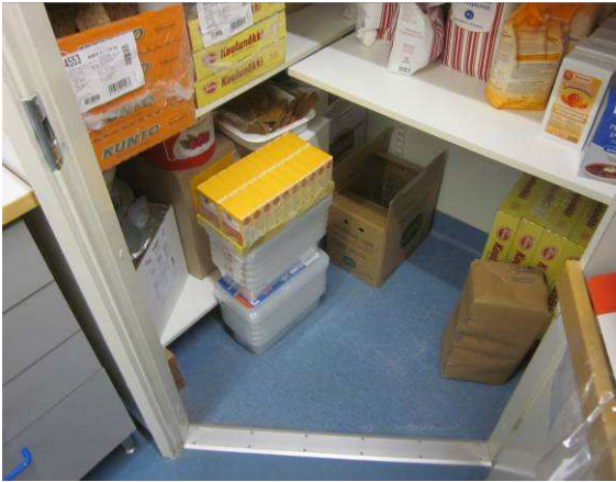
Ruokavarasto, ei kohonneita kosteuspitoisuuksia
