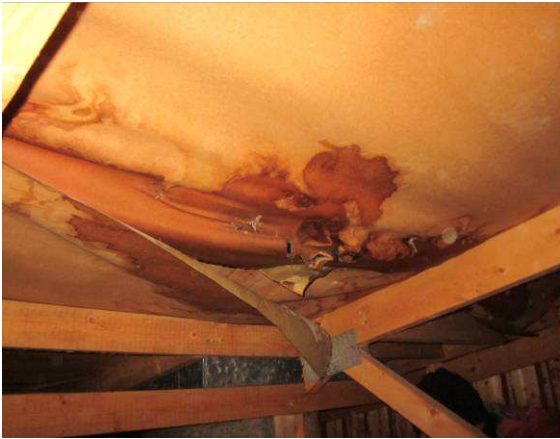
Kattovuoto iv- konehuoneen yläpuolella
