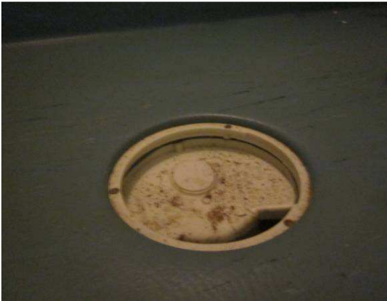
Lattiakaivon liitoksissa ei havaittu puutteita, kiristysrenkaat paikallaan
