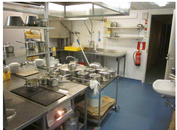
Keittiön tiskausalueella havaittiin kohonneita kosteuspitoisuuksia
