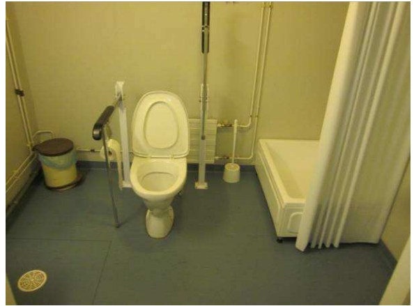
Erillisissä wc-tiloissa ei havaittu kohonneita kosteuspitoisuuksia
