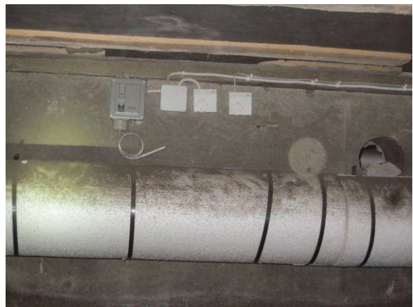
Alapohjatilan ilmanvaihtoa ohjataan kosteuden ja lämpötilan mukaan
