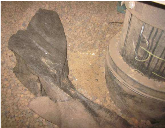
Kevytsoran alla suodatinkankaan alapuolella on hienorakeinen hiekka
