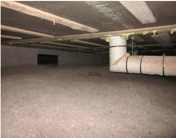
Kuvaa sepelipohjaiselta osalta, viemärit on eristetty asianmukaisesti
