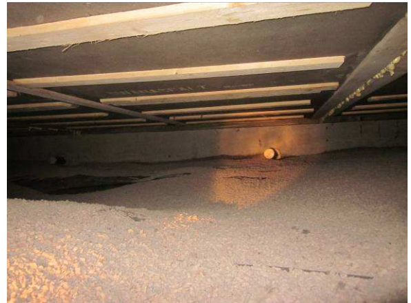
Bituliiteissä ja niiden kannatuslaudoissa ei havaittu viitteitä kosteusongelmista
