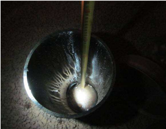
Kuvaa alapohjatilassa länsisivulla olevasta tarkastuskaivosta, vedenpinta on putkien alapuolella noin 130cm bituliitistä
