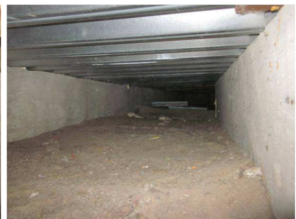
Kuvaa länsisivulta sisäänkäyntisyvennyksen alta, ei merkittävästi kohonnutta kosteutta
