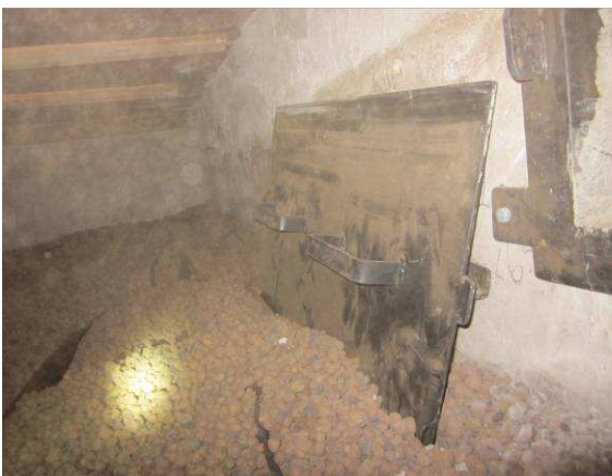
Länsiosaan on kulku teräsluukkujen kautta
