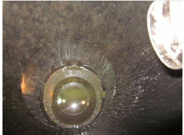
Kuvaa alapohjatilassa pohjoissivulla olevasta tarkastuskaivosta, vedenpinta on putkien alapuolella noin 140cm bituliitistä
