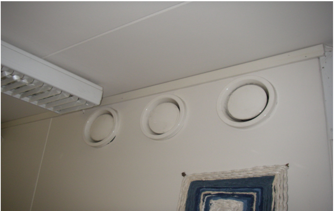
KUVA 38. Yleiskuva poistoilmaventtiileistä.
