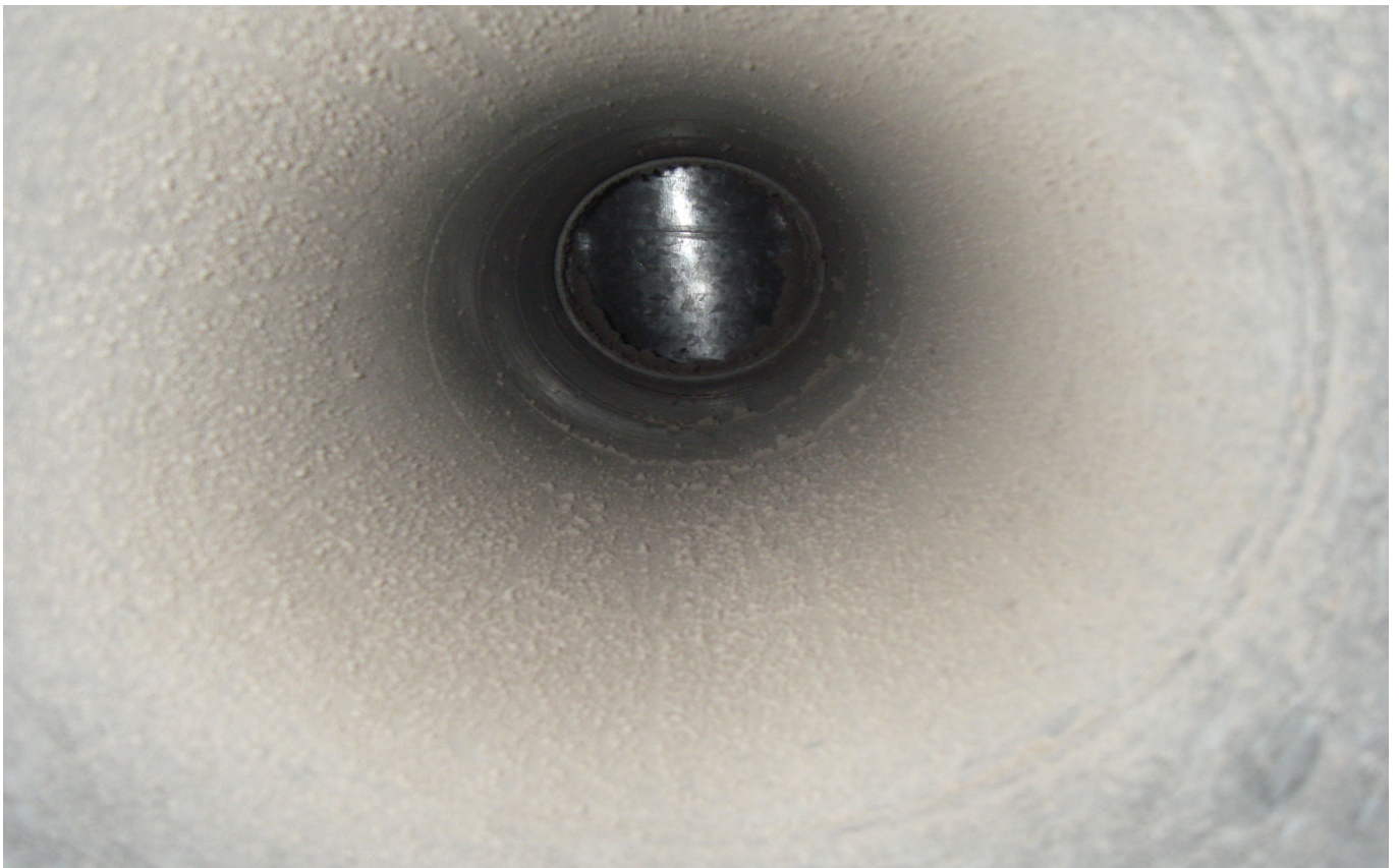
KUVA 34. Yleiskuva lisärakennuksen poistoilmakanavasta.
