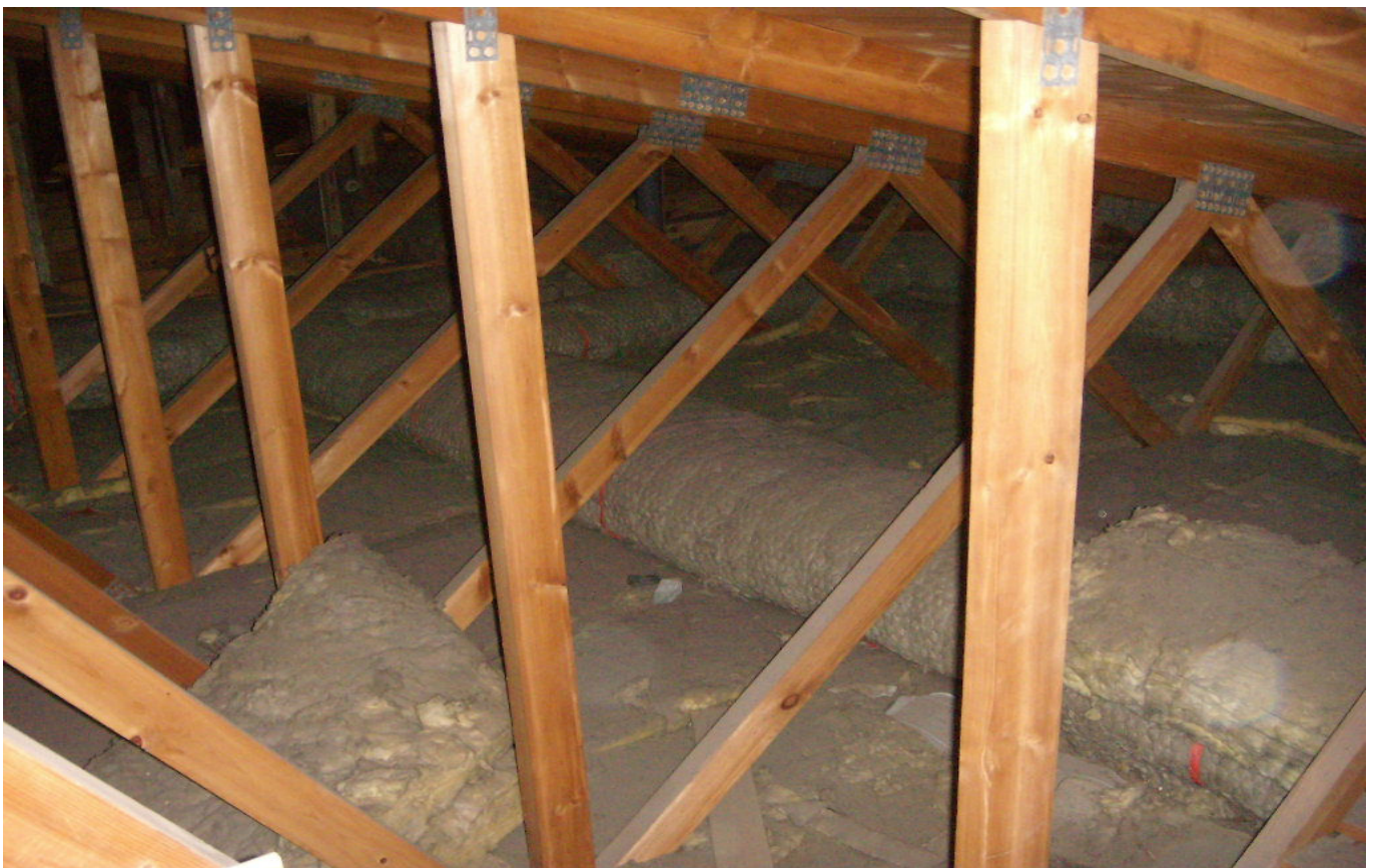
KUVA 32. Yleiskuva päärakennuksen ullakkotiloista.
