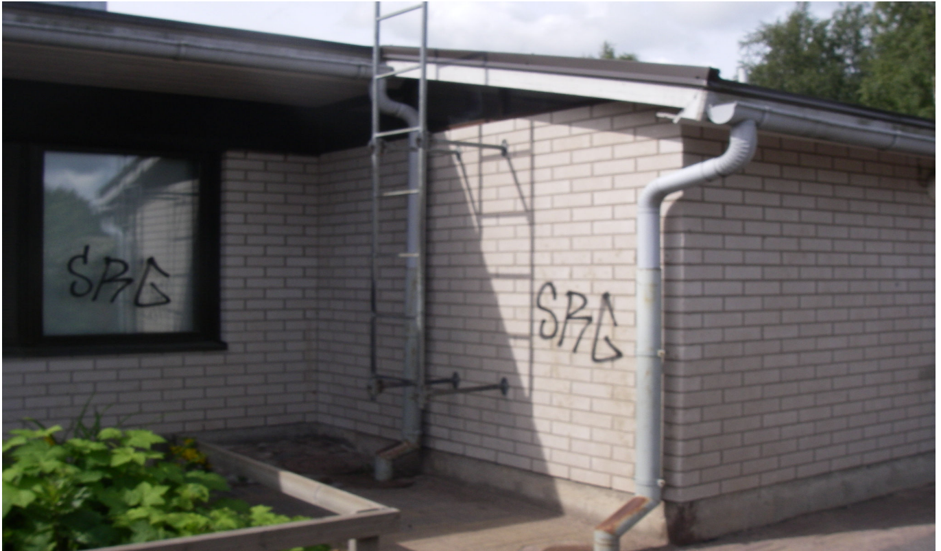
KUVA 41. Yleiskuva päärakennuksen seinustalla olevista tikkaista.
