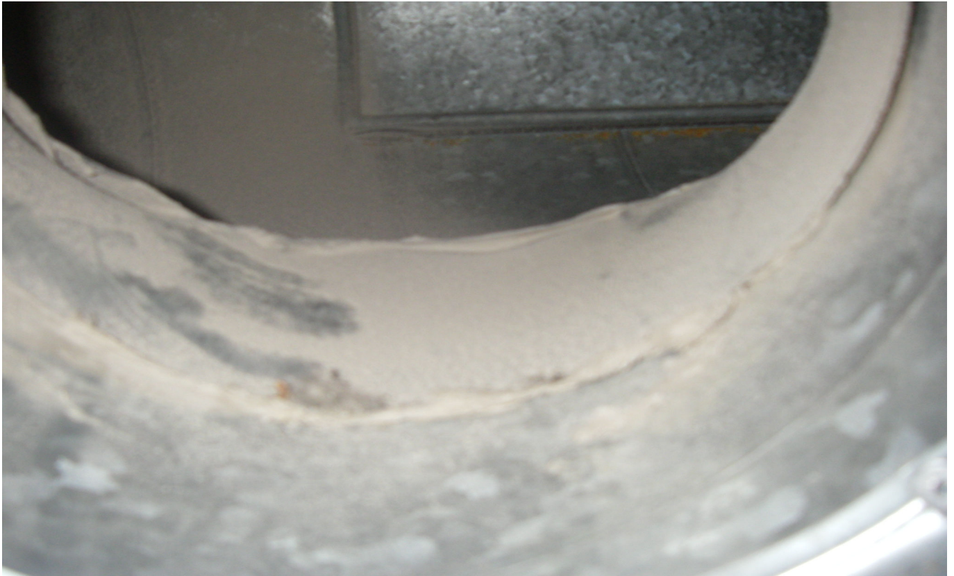
KUVA 27. Yleiskuva päärakennuksen poistoilmakanavasta.
