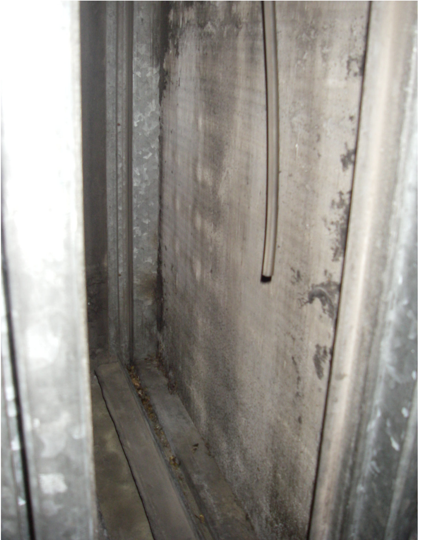
KUVA 7. Yleiskuva päärakennuksen tuloilmakoneen lämpöpatterista.
