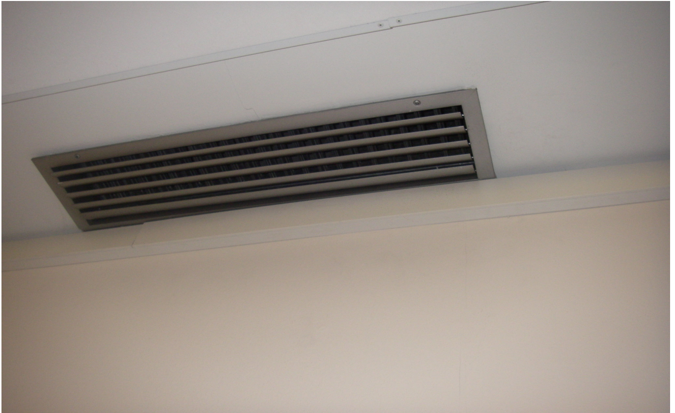
KUVA 35. Yleiskuva päärakennuksen kattohajottajasta.
