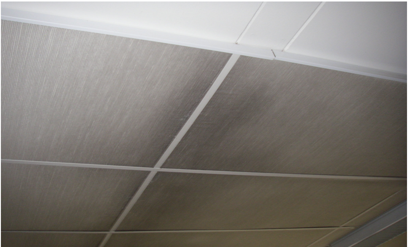
KUVA 46. Yleiskuva lisärakennuksen katosta.
