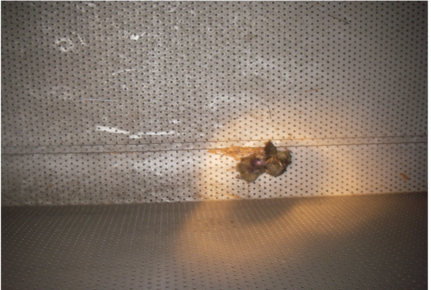
KUVA 12. Yleiskuva päärakennuksen tuloilmakammioista.
