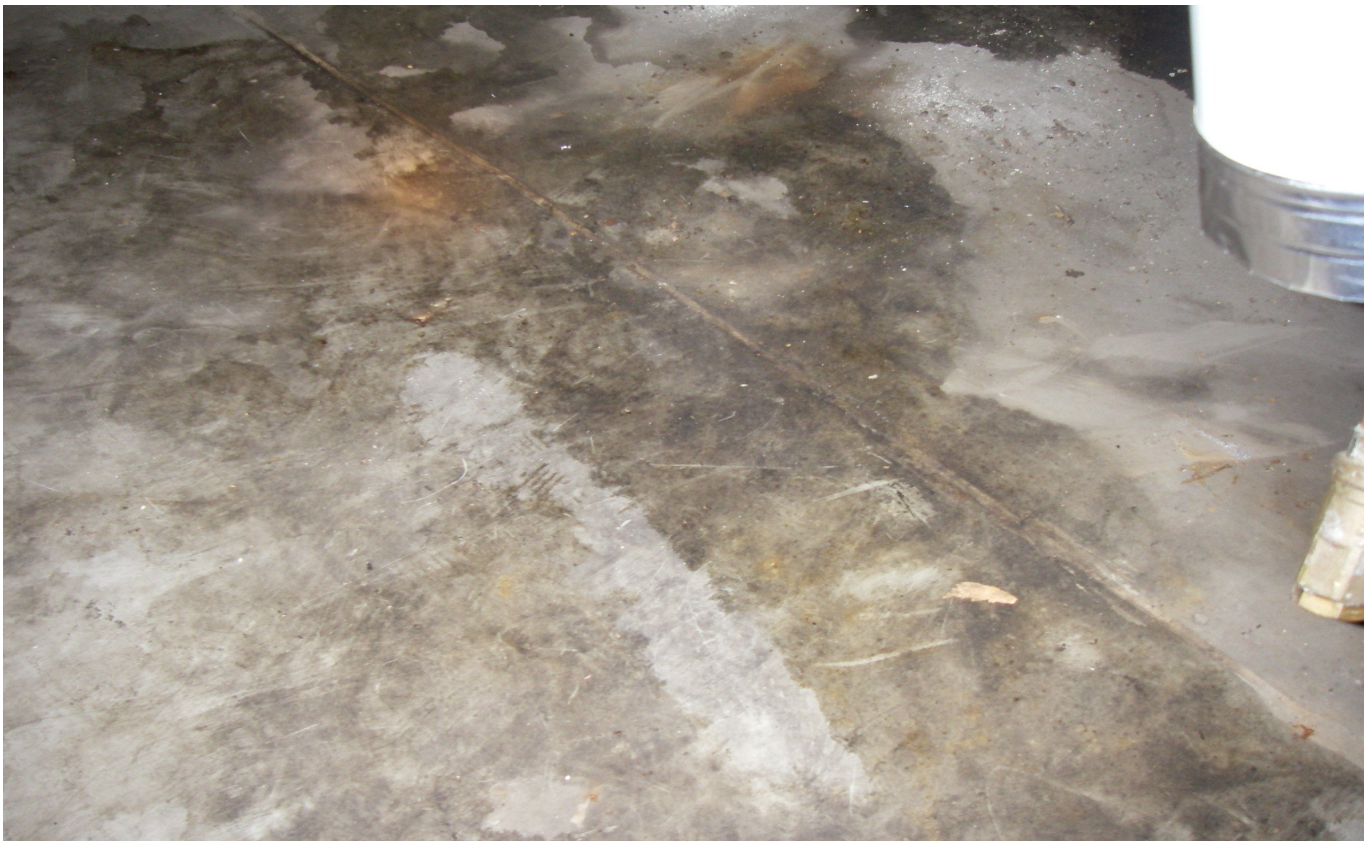
KUVA 4. Yleiskuva päärakennuksen ilmastointihuoneen muovimatosta.
