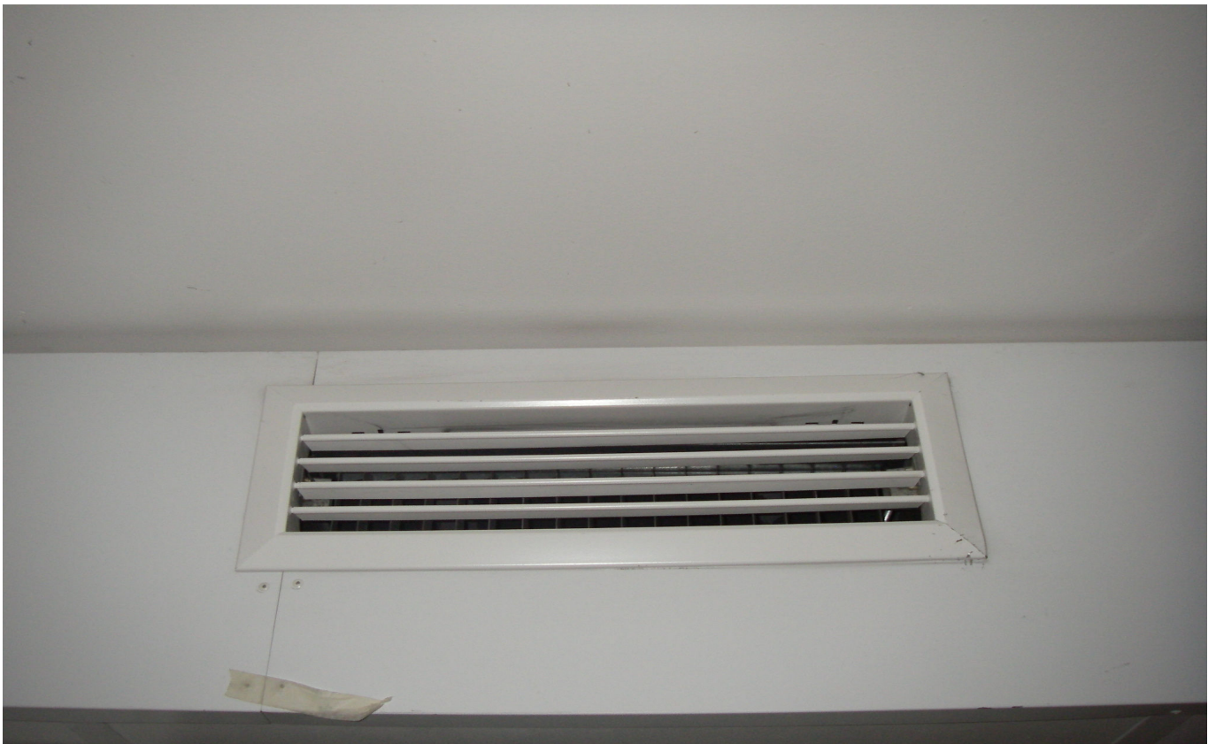
KUVA 36. Yleiskuva päärakennuksen ritiläsäleiköstä.
