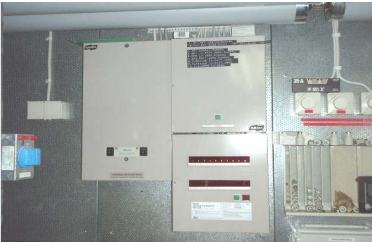
S-KUVA 13. Ovimerkkivalaistuksen keskus ja LVI- hälytyskeskus
