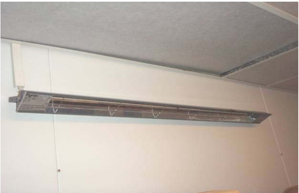
S-KUVA 9. Vesileikkitilan säteilylämmitin
