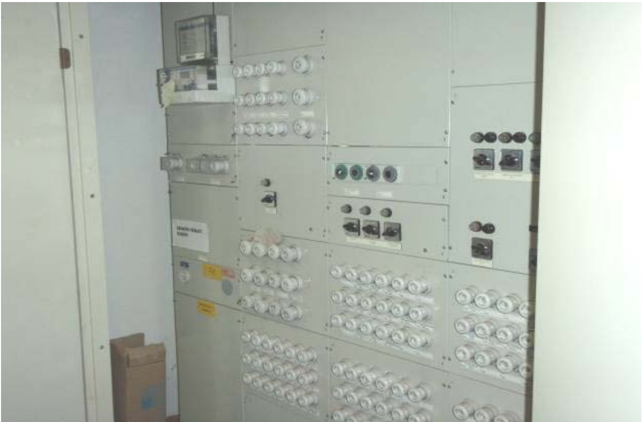
S-KUVA 3. Sähköpääkeskus
