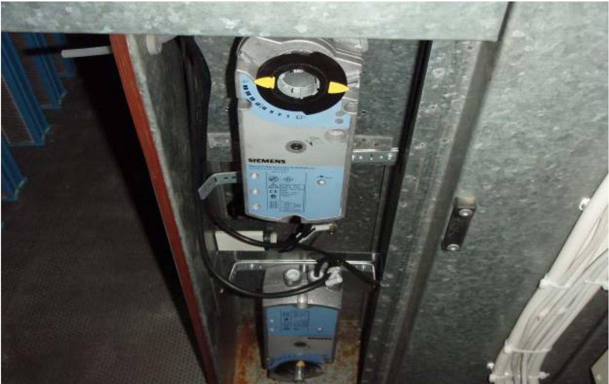
S-KUVA 16. Peltimoottorit
